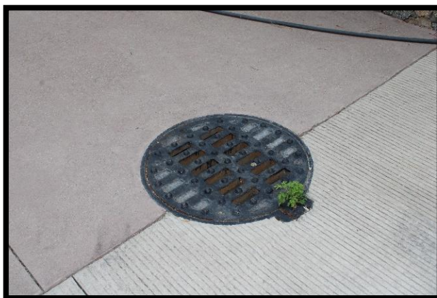
Figura II.32. Alcantarillado para el drenaje de aguas de lluvias.
