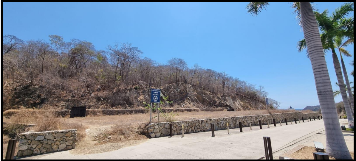
Figura VII.67. Estado actual del Lote 08, Manzana 2.
