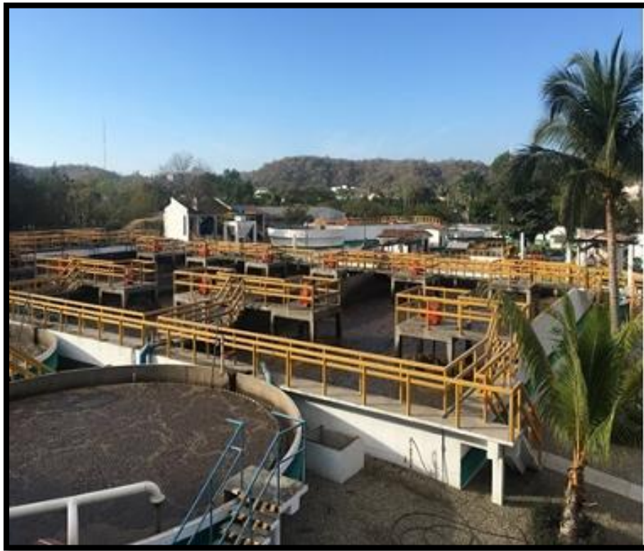
Figura II.26. Planta de tratamiento de aguas residuales (PTAR) Chahue.
