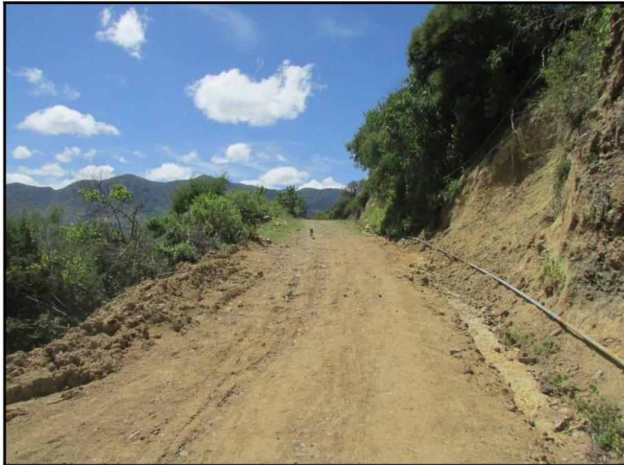
Fotografía 3. Las condiciones del camino existente (calle urbana) en época de lluvias se vuelve intransitable para los vehículos automotores, dejando sin acceso a los terrenos de cultivo más cercanos.
