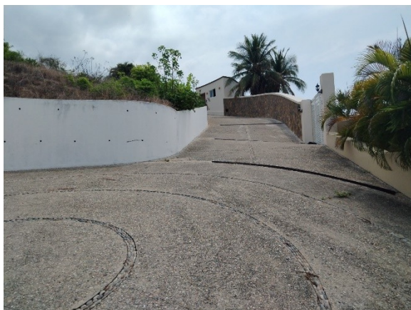
Vialidad interna de acceso al terreno
