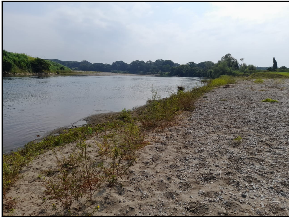
Fotografía 5. Condiciones actuales del cauce del río, se aprecia el abundamiento del material, lo que provoca inundaciones en sitios aledaños en temporadas de lluvias.
