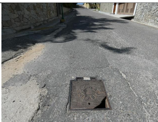
Existencia de agua potable.
