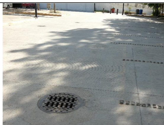
Existencia de alcantarillado sanitario.
