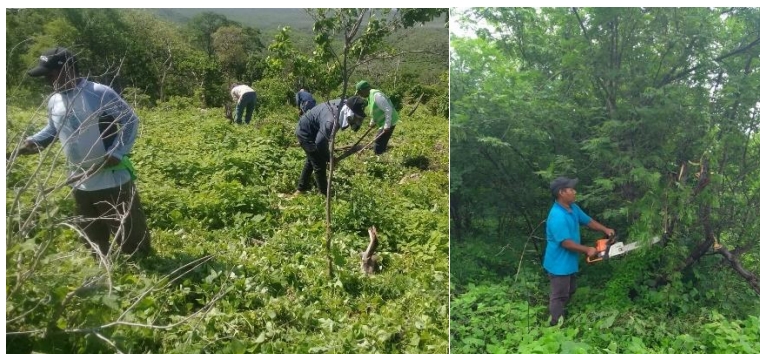
Ejemplo de desmonte con herramienta manual.
