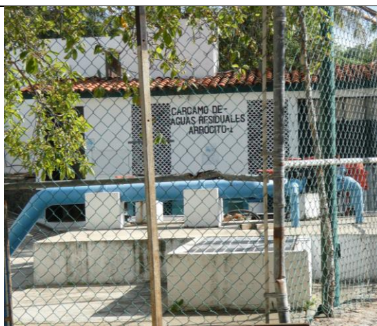
Cárcamo de aguas residuales, el cual se ubica dentro de la zona del proyecto.
