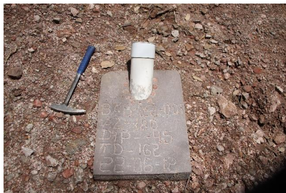
Figura III.6. Ejemplo de sellado de barreno.
