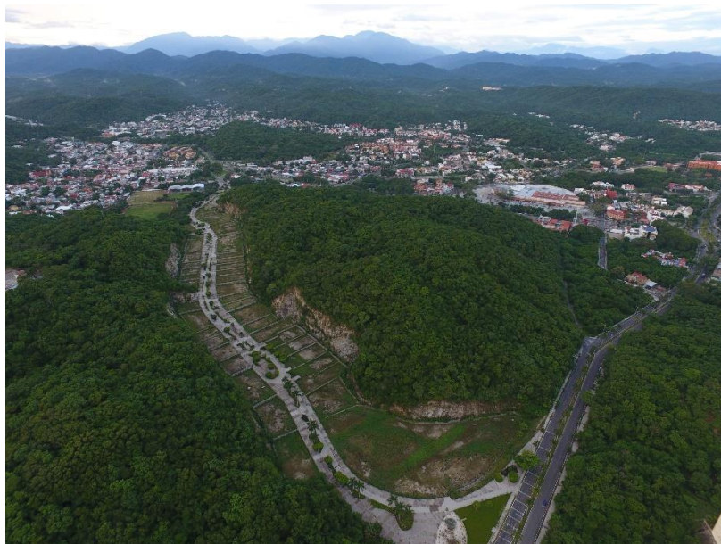
Aspecto del Corredor turístico y la zona urbana de la Agencia Municipal de Santa Cruz Huatulco.
