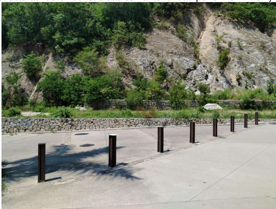
Aspecto del lote 21 confinado al frente y lateralmente por muros de piedra braza de la región y por un muro de gaviones en la parte posterior que previenen el daño por derrumbes y evitan el paso al espacio en estado natural que se encuentra detrás (estas estructuras fueron construidas con anterioridad por el FONATUR)
