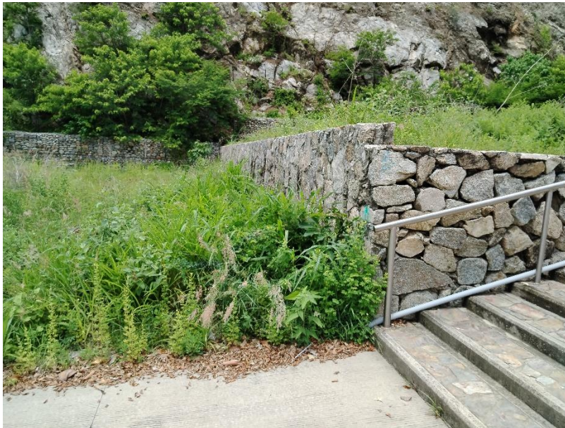
Aspecto del lote 18 confinado al frente y lateralmente por muros de piedra braza de la región y por un muro de gaviones en la parte posterior que previenen el daño por derrumbes y evitan el paso al espacio en estado natural que se encuentra detrás (estas estructuras fueron construidas con anterioridad por el FONATUR)
