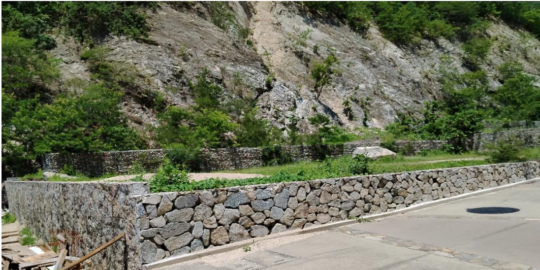
Muro de contención de una plataforma; en la parte posterior muro de gaviones
