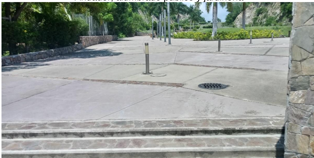
Andador, alumbrado público y pozo de visita del colector sanitario Corredor Turístico Santa Cruz – La Crucecita
