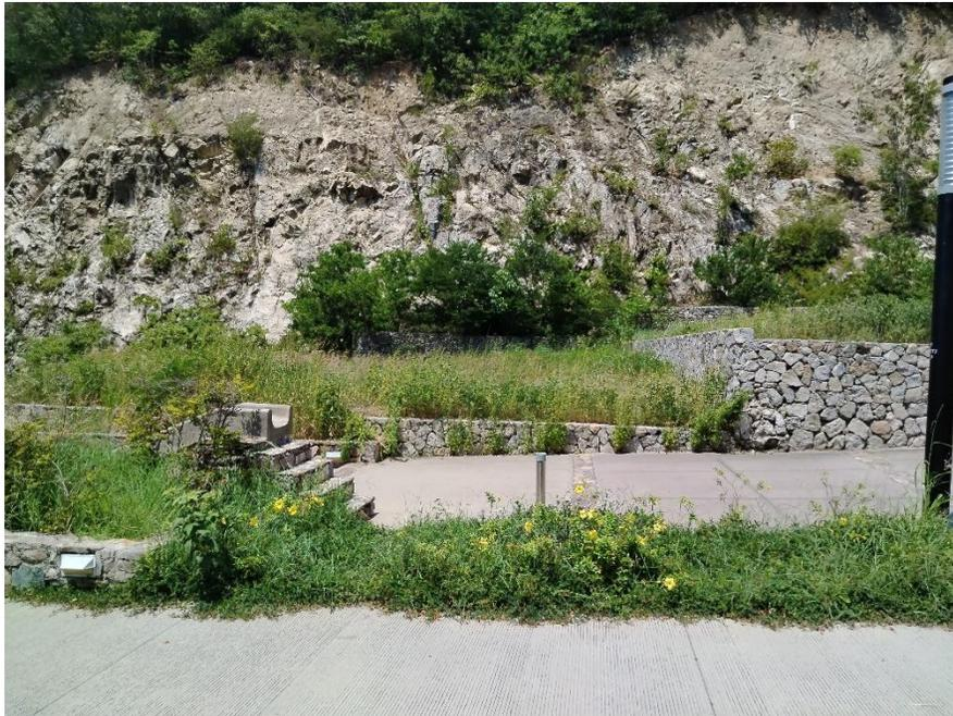
Aspecto del lote 17 confinado al frente y lateralmente por muros de piedra braza de la región y por un muro de gaviones en la parte posterior que previenen el daño por derrumbes y evitan el paso al espacio en estado natural que se encuentra detrás (estas estructuras fueron construidas con anterioridad por el FONATUR)
