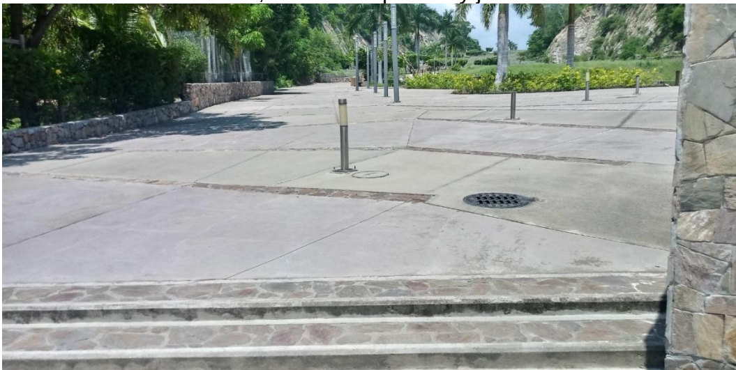
Andador, alumbrado público y pozo de visita del colector sanitario
