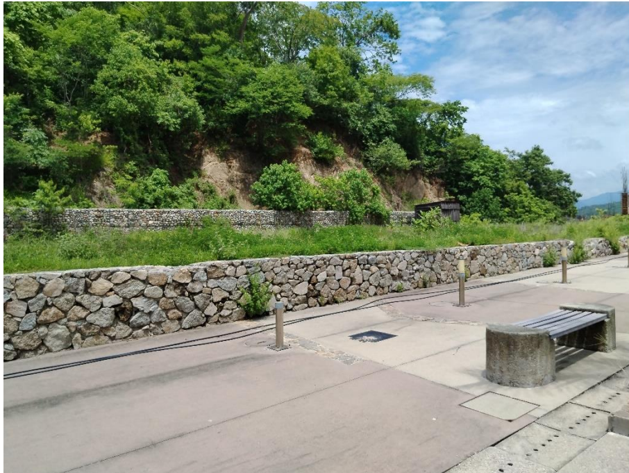
Aspecto del lote 16 confinado al frente y lateralmente por muros de piedra braza de la región y por un muro de gaviones en la parte posterior que previenen el daño por derrumbes y evitan el paso al espacio en estado natural que se encuentra detrás (estas estructuras fueron construidas con anterioridad por el FONATUR)
