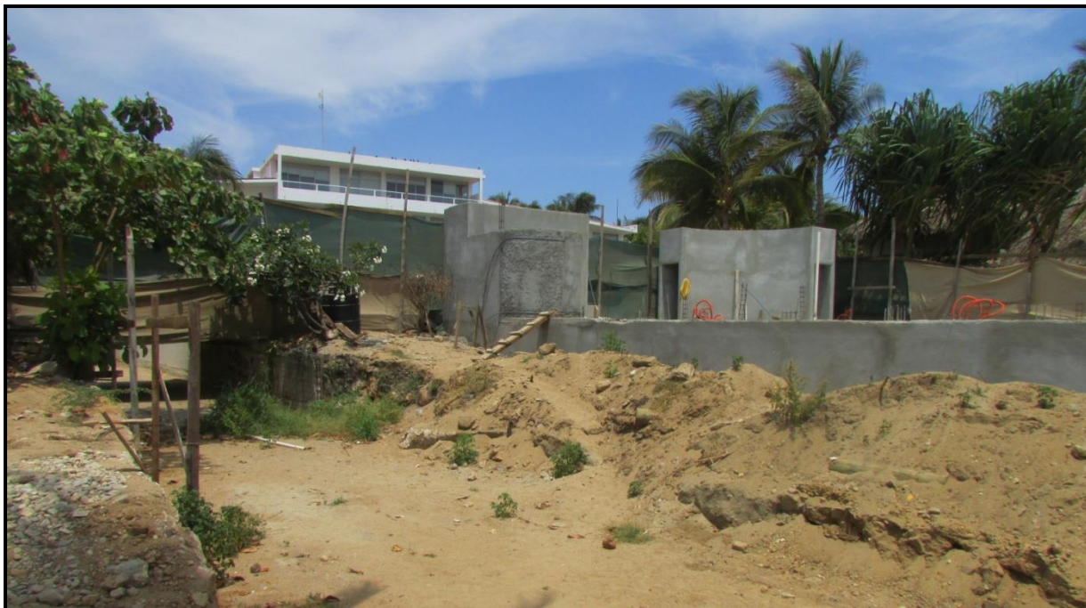
Fotografía 1. Condiciones actuales del sitio del proyecto en la colindancia norte, donde se localiza un canal de aguas pluviales que se conduce a la playa Zicatela; en esta colindancia el municipio de Santa María Colotepec tiene proyectada la construcción de un muro de contención para el encauzamiento de las aguas pluviales y evitar afectaciones a los terrenos colindantes.
