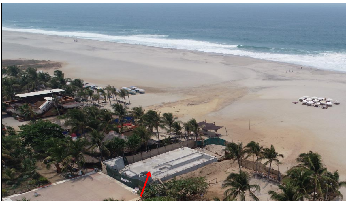
Fotografía 7. Vista Noreste del sitio del proyecto, en donde se aprecia el avance de la obra del club de playa y sus alrededores. Actualmente las actividades de construcción se encuentran suspendidas de manera temporal hasta obtener la autorización en materia de impacto ambiental correspondiente.
