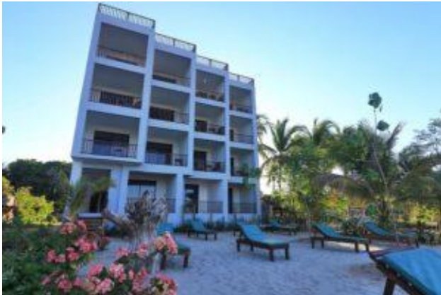
Edificación en Punta Zicatela (Brisas de Zicatela)
