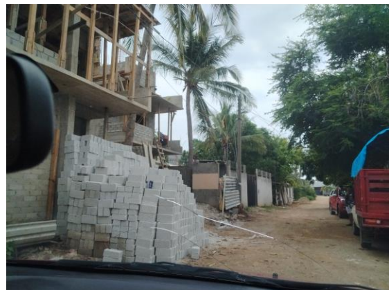
Aspecto de edificación en proceso en Punta Zicatela (Brisas de Zicatela)
