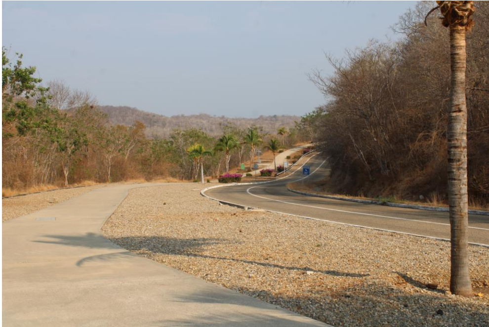
Figura 14.-Vialidades de acceso y servicios ubicados en el sitio del proyecto.
