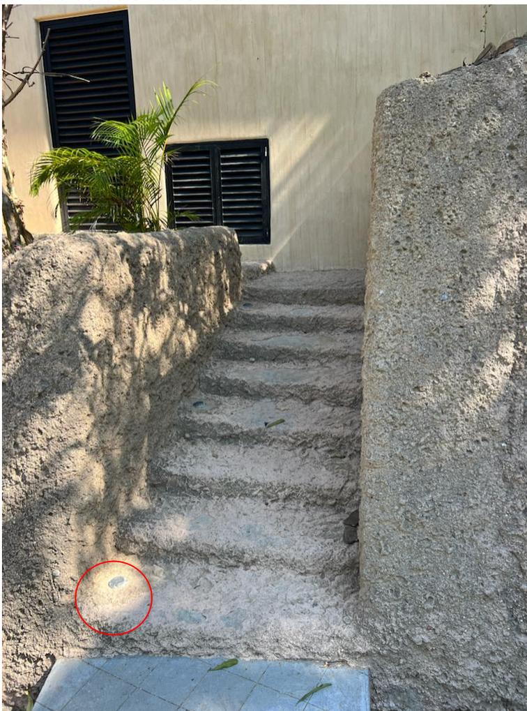
Figura 6. Acabo aparente del suelo cemento. Este mismo acabado se utilizará en el proyecto para el recubrimiento de la escalera. Nótese el detalle enmarcado en el círculo rojo mostrando el tipo de iluminación que se utilizará.
