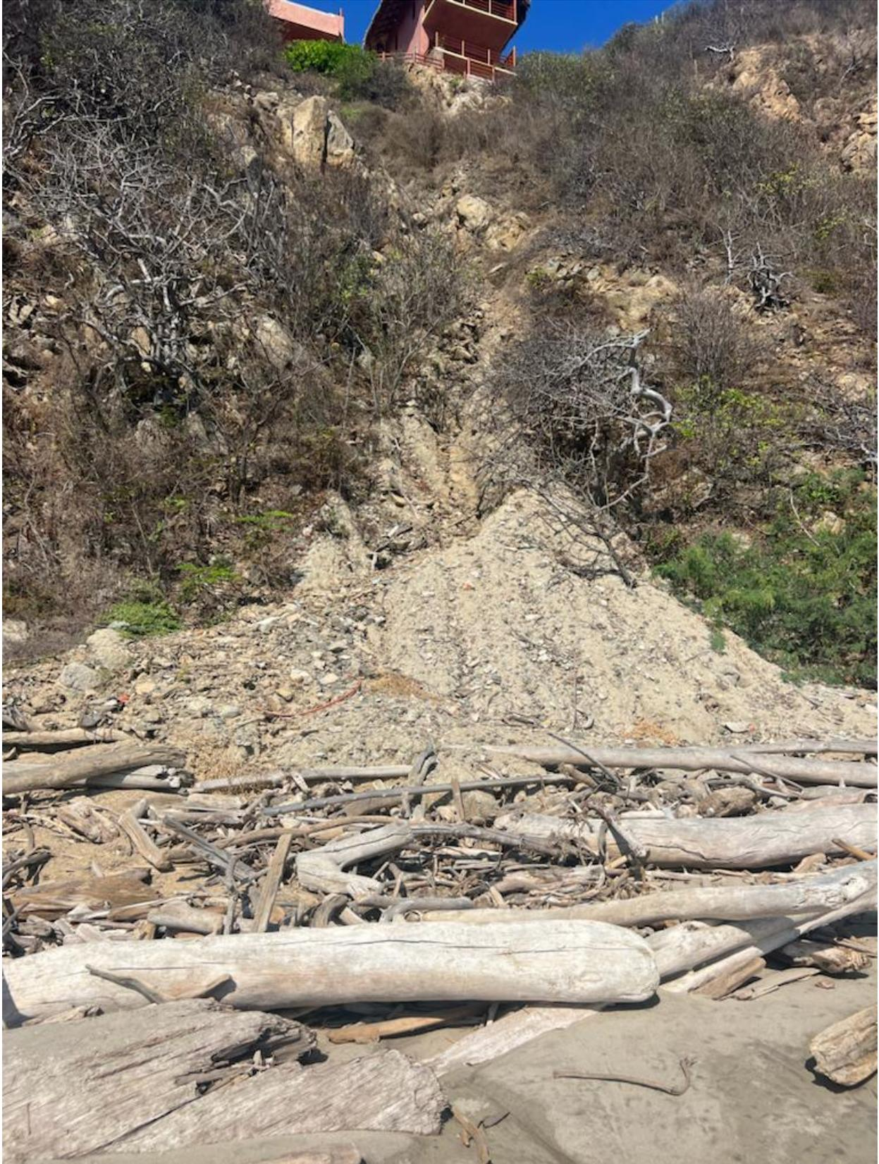
Figura 24 Evidencia de erosión pluvial en el sitio del proyecto
