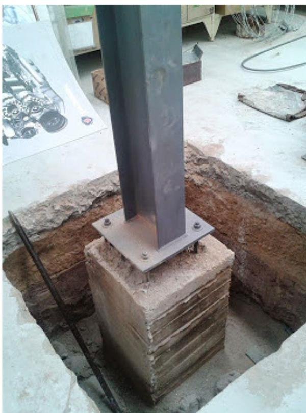
Figura 5 Sistema de cimentación de zapata y dado.
