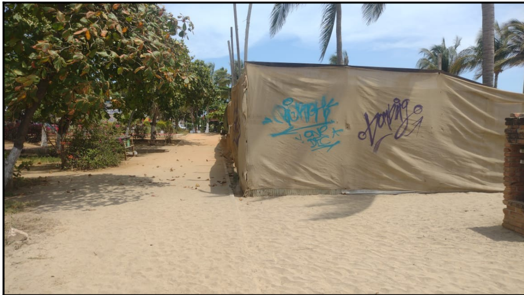
Fotografía 4. Colindancia Sureste del polígono del proyecto, nótese un andador existente que forma parte de las áreas verdes recreativas colindantes a la avenida El Morro, vialidad principal de acceso a la playa Zicatela y establecimientos comerciales de la zona.
