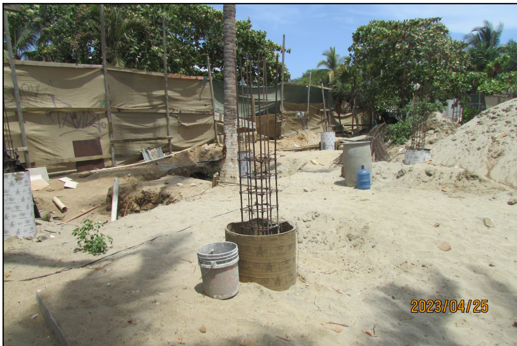
Fotografía 3. Vista de las columnas que se encontraban en proceso de construcción al momento de la visita de inspección por parte de la PROFEPA.
