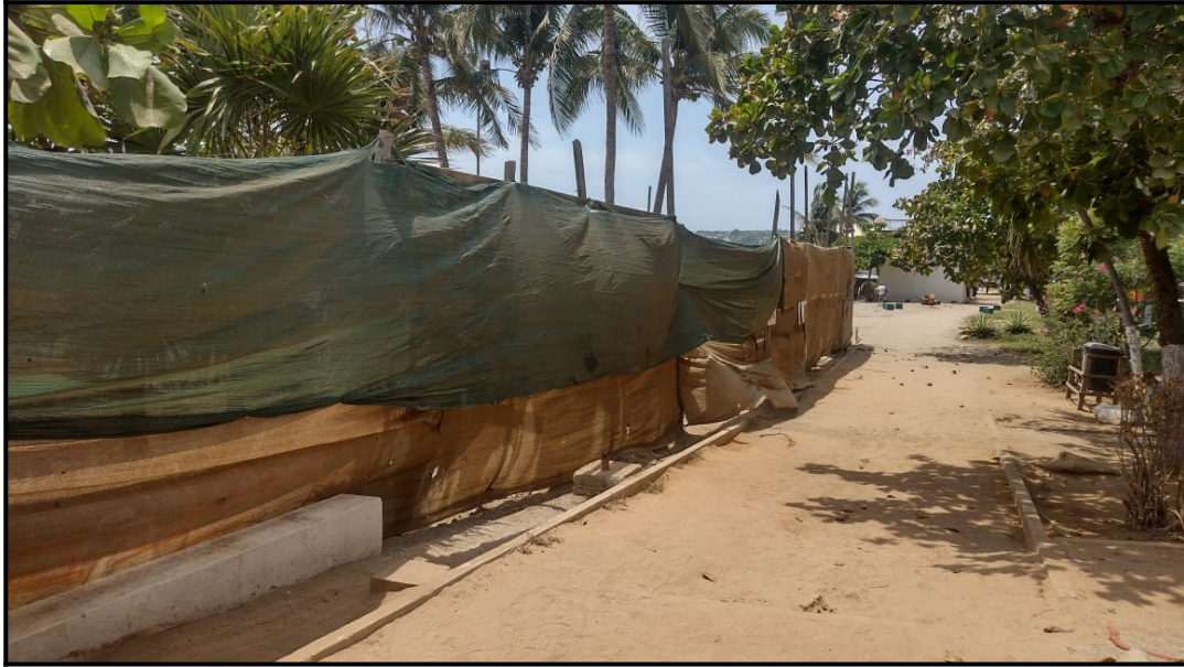
Fotografía 7. Panorama actual de la colindancia Este del predio del proyecto, en donde se encuentra un andador de acceso paralelo a la avenida El Morro, mismo que es utilizado para recorrer los establecimientos comerciales y áreas ajardinadas colindantes a la zona federal marítimo terrestre de la playa Zicatela.
