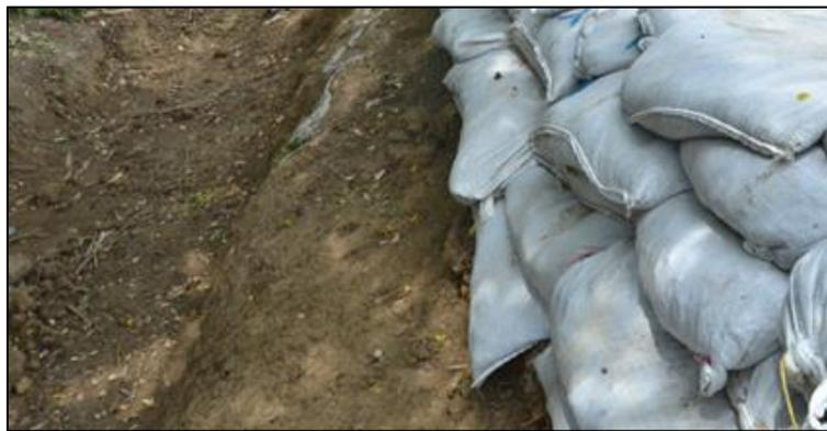
**Figura 2.8.** Ejemplos de costaleras o muro a base de costales de rellenos de arena para protección de obra constructiva
