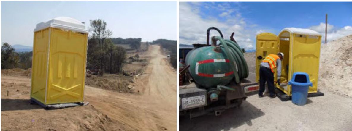
Imagen VI.1. Ejemplo de la colocación de sanitarios portátiles.
