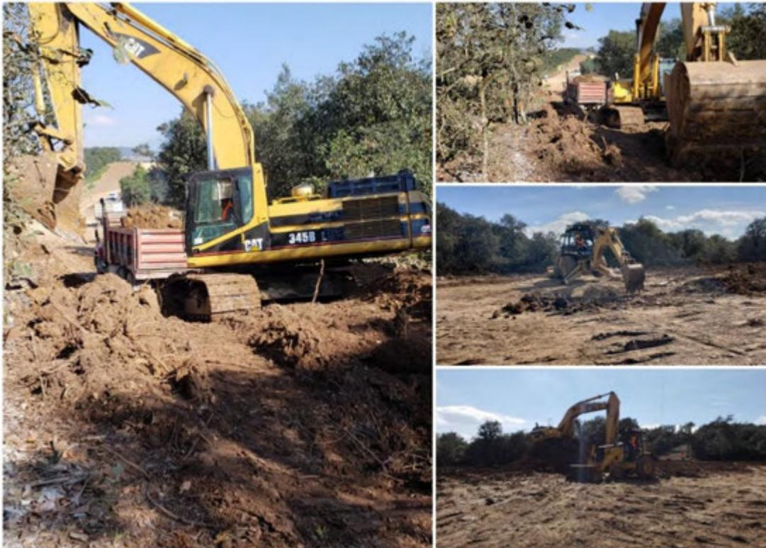
Imagen II.29. Ejemplo de la maquinaria para llevar a cabo la extracción de materiales pétreos.
