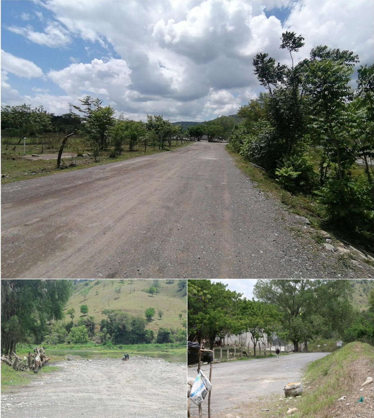
**Imagen II.22. Por la actividad pretendida no se requiere la apertura de caminos de acceso, ya que serán utilizados los ya existentes, mismos que se encuentran en buen estado conformados en terracería.**
