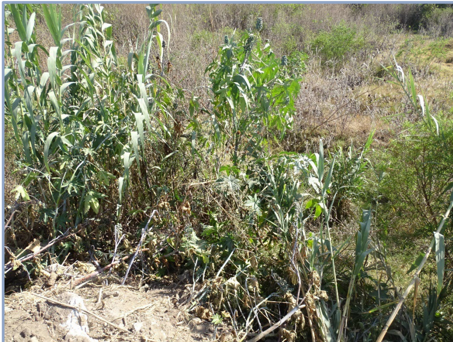
A-106 Lav 2 Descarga pluvial
