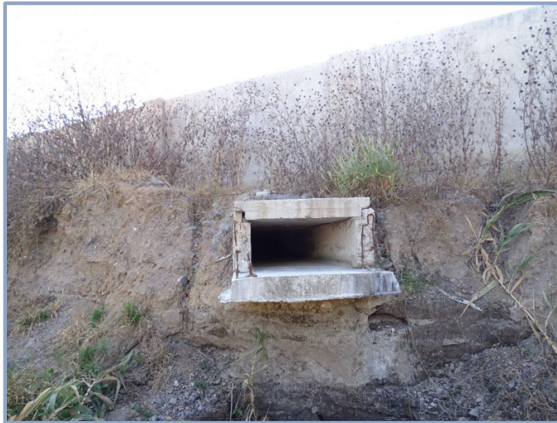
Figura No. 8 Ejemplo de Descarga pluvial Cajón con concreto en obra.
