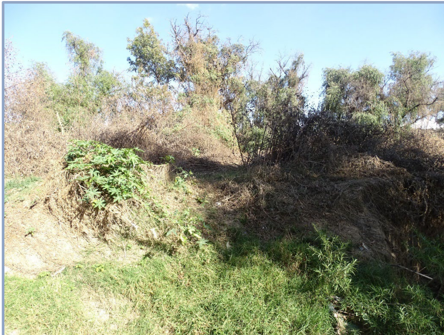
A-106 Lav 4 Descarga pluvial
