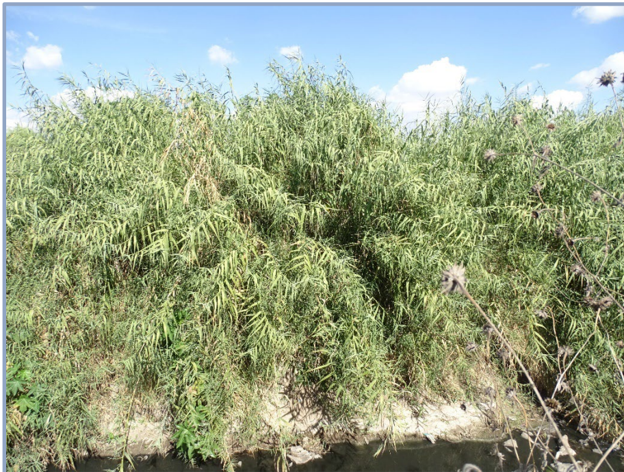
A-103 Lav 1 Descarga pluvial
