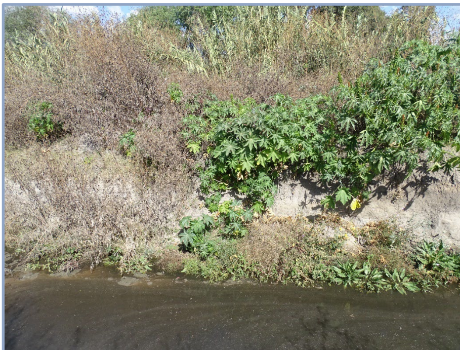
A-103 Cajón 1 Descarga pluvial
