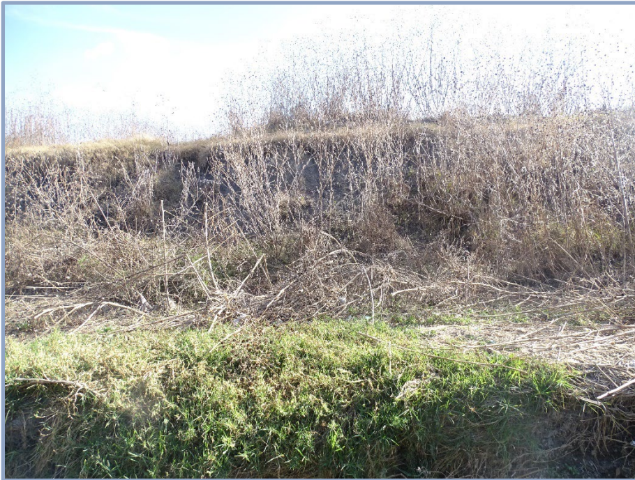
A-106 Lav 6 Descarga pluvial
