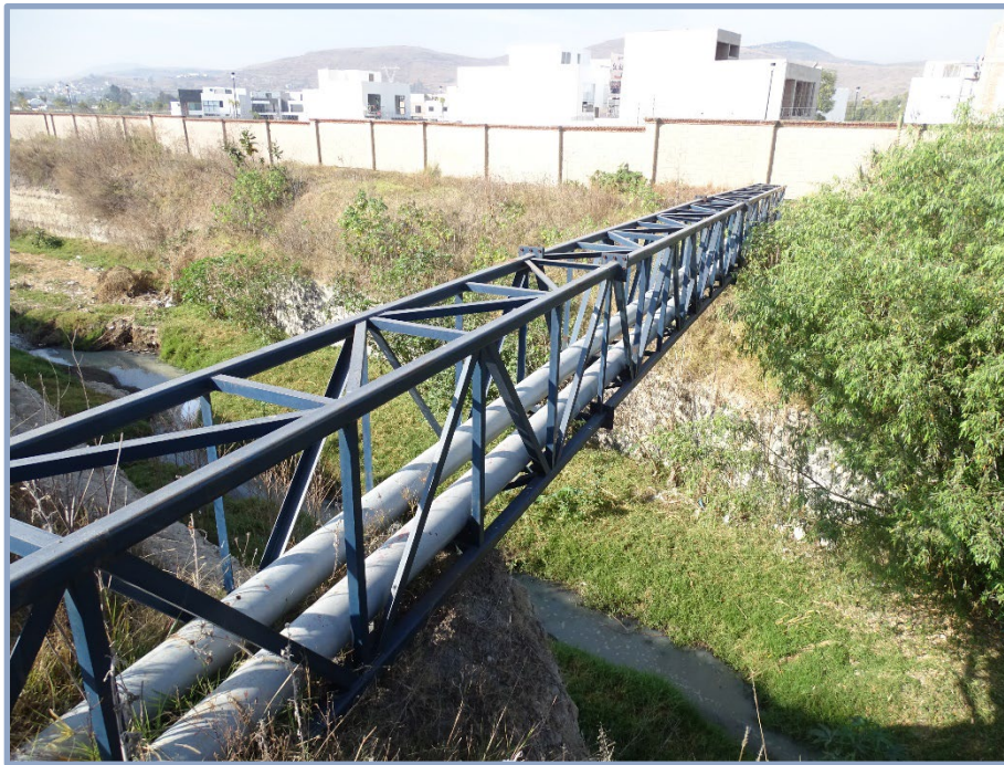
A-82 Cruce drenaje sanitario
