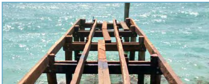
Figura II_ 19. Estructura de soporte de la cubierta.
