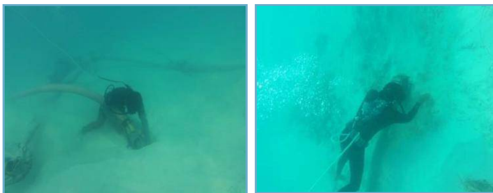
Figura II_ 30. Succión de arena mediante tubería y mangueras.
