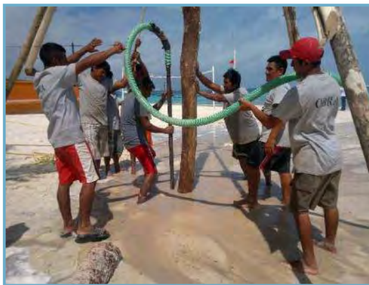
Figura II_ 18. Proceso de chifoneo y colocación de pilotes de soporte.
