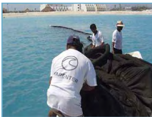
Figura II_ 28. Colocación y funcionamiento de malla antidispersión, en proyectos similares.
