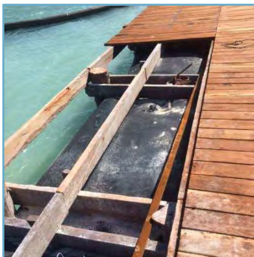
Figura II_ 22. Ejemplo de andador reforzado con tubos de geotextil rellenos con arena.
