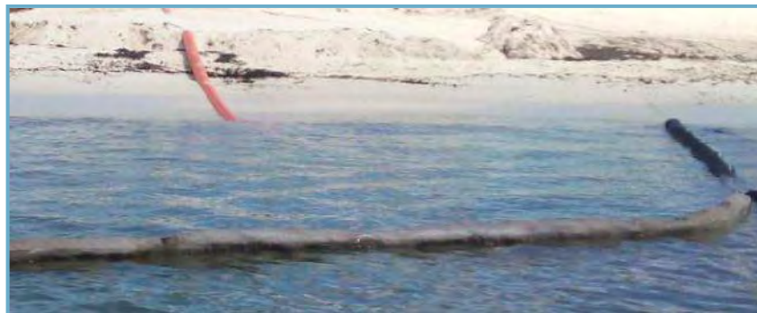
Figura II_ 29. Descarga de arena sobre la playa.
