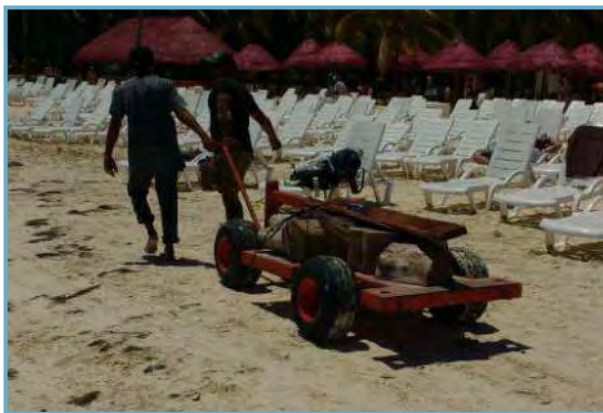
Figura II_ 17. Traslado de madera al área de playa del proyecto.
