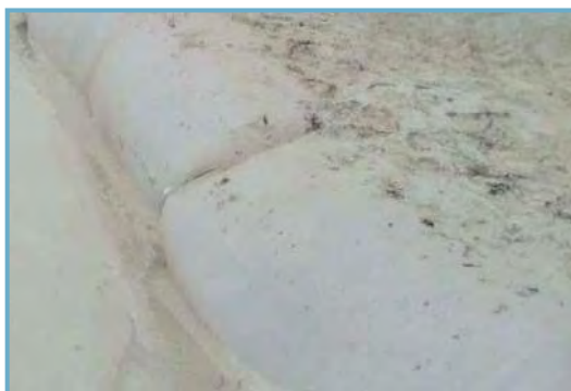
Figura II_ 16. Ejemplo de elemento de geotextil temporal de apoyo para retención de arena en la playa.
