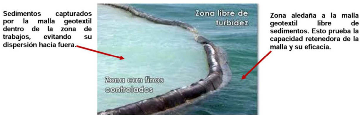
Figura 9. En la imagen de arriba, se observa una ejemplificación de la forma correcta de colocar la malla geotextil perimetral, para evitar la dispersión de sedimentos, boyas flotantes en la parte de arriba y plomos en la parte inferior. En la imagen de bajo se observa una malla ya colocada, se aprecia con claridad el efecto mitigador de la malla para evitar la dispersión de sedimentos.
