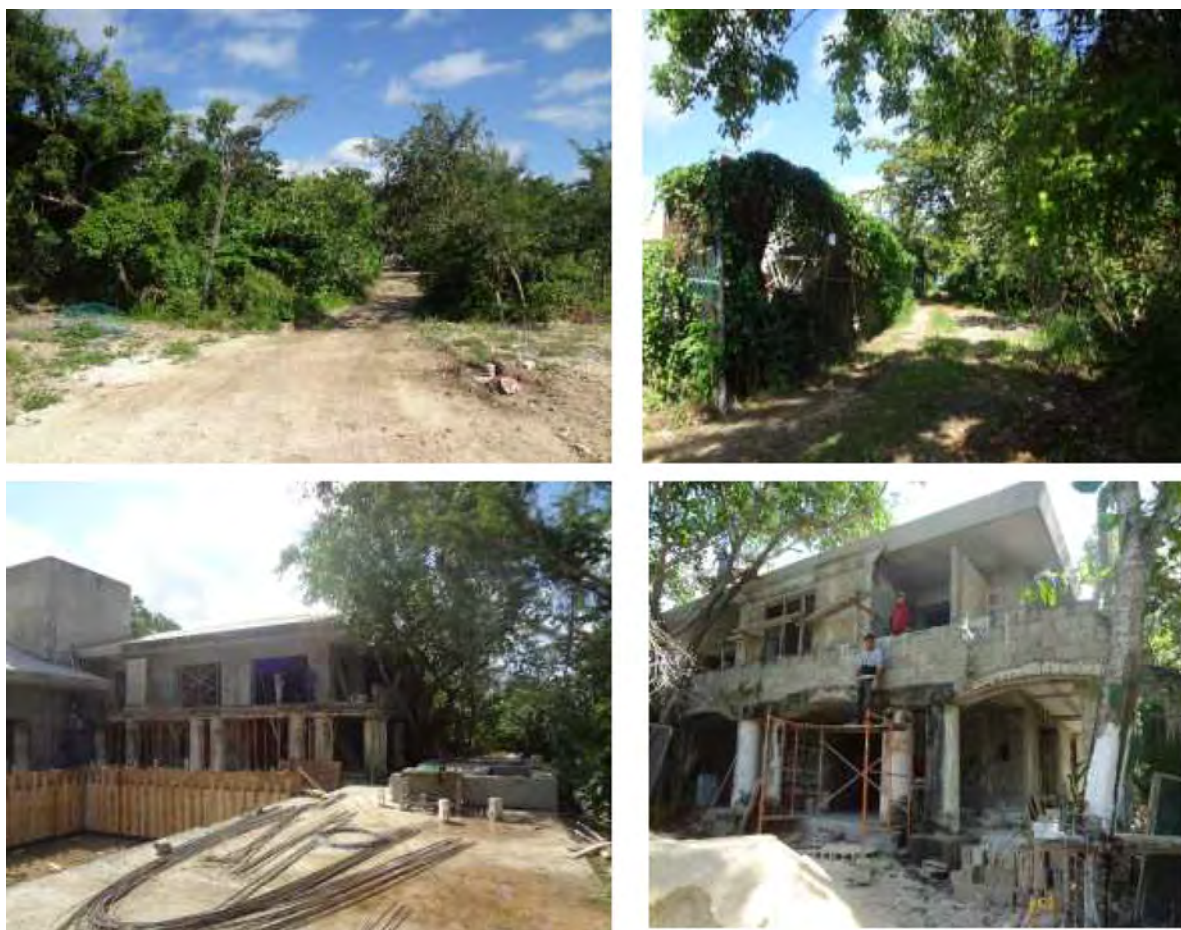
Figura 3. Caminos de acceso a la Villa 1 y remodelación de la Casa existente.
