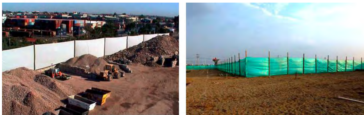
Figura V-5 Ejemplo de mamparas rompevientos
