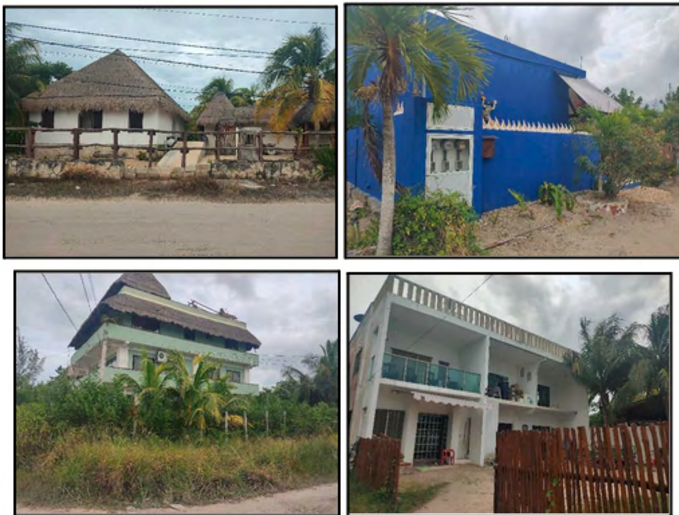
Figura III-6 Infraestructura observada en la zona
