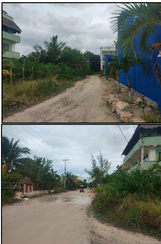
Figura IV.16. Calle secundaria por la que se accede al predio y avenida Pedro Joaquín Caldwell.
