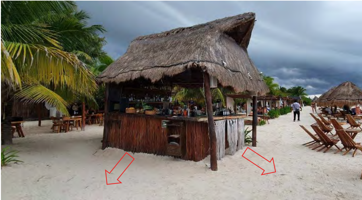
Imagen 21. Palapa bar tiki para ampliación
