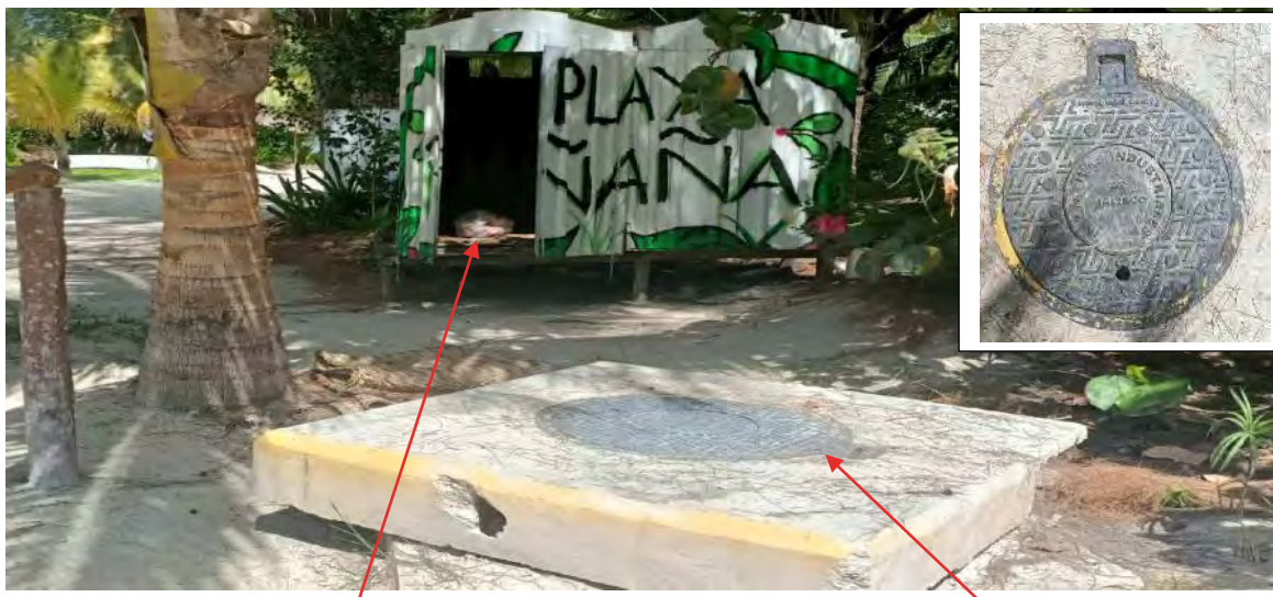
Área de Trasferencia de residuos y Conexión con drenaje Municipal
