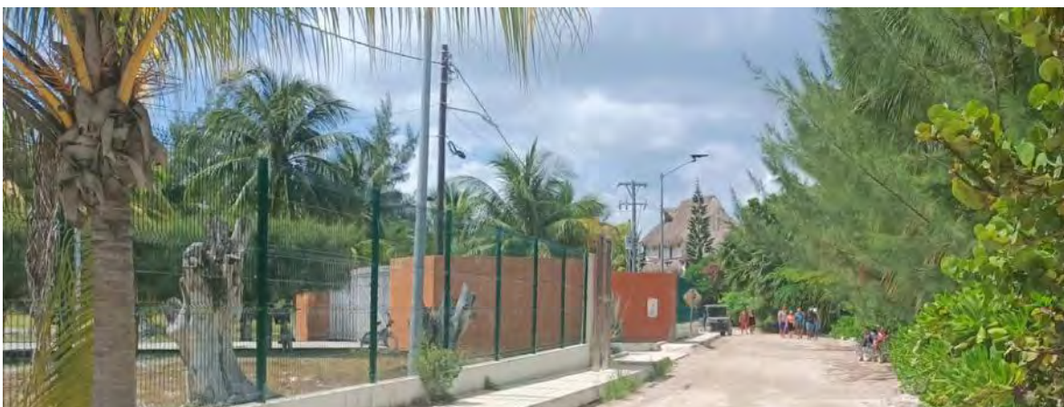
Postes de energía eléctrica sobre la Av. Damero (C.F.)
