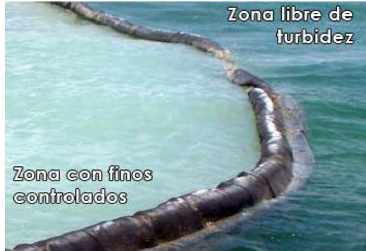
**Figura 6.** Se muestra a manera de ejemplo el funcionamiento de la malla antidispersión.
