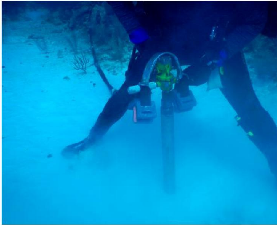
Figura 4.- Taladro hidráulico con el cual se realizan las perforaciones en la roca calcárea.
