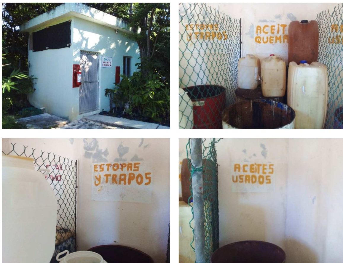
Figura 7. Se muestran algunas vistas del exterior e interior del Almacén de Residuos Peligrosos de la PTAR.
