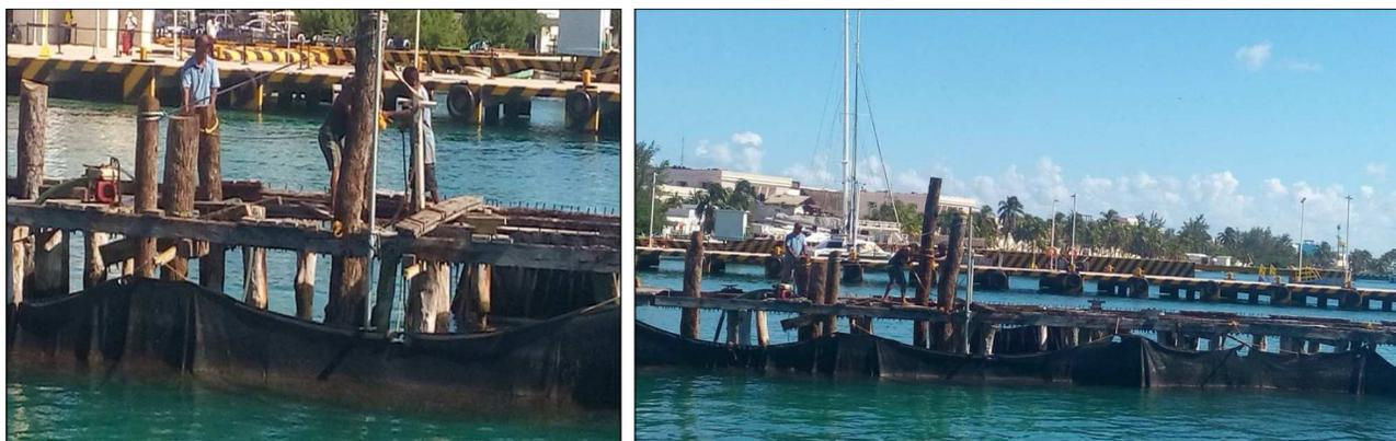
Figura 8. Se muestra la forma del hincado y la malla protectora.
