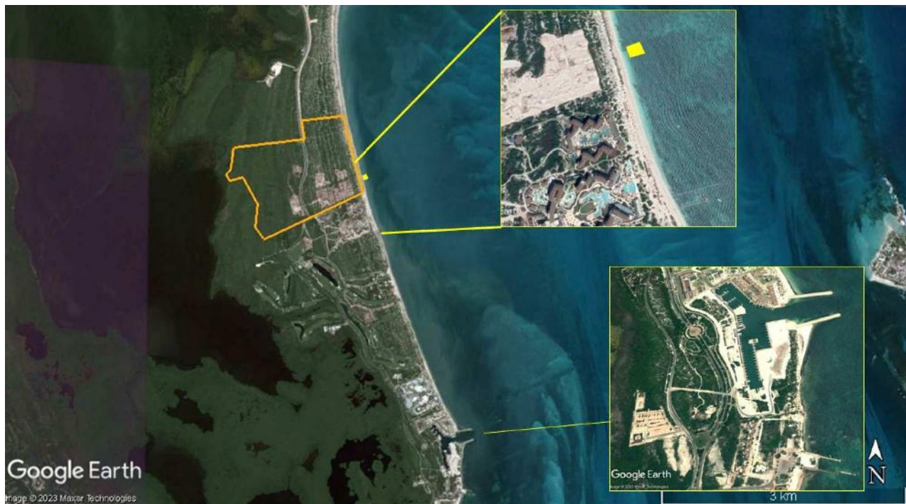
Figura 7.10. Obras marinas al sur del Proyecto GPPM en 2017.
