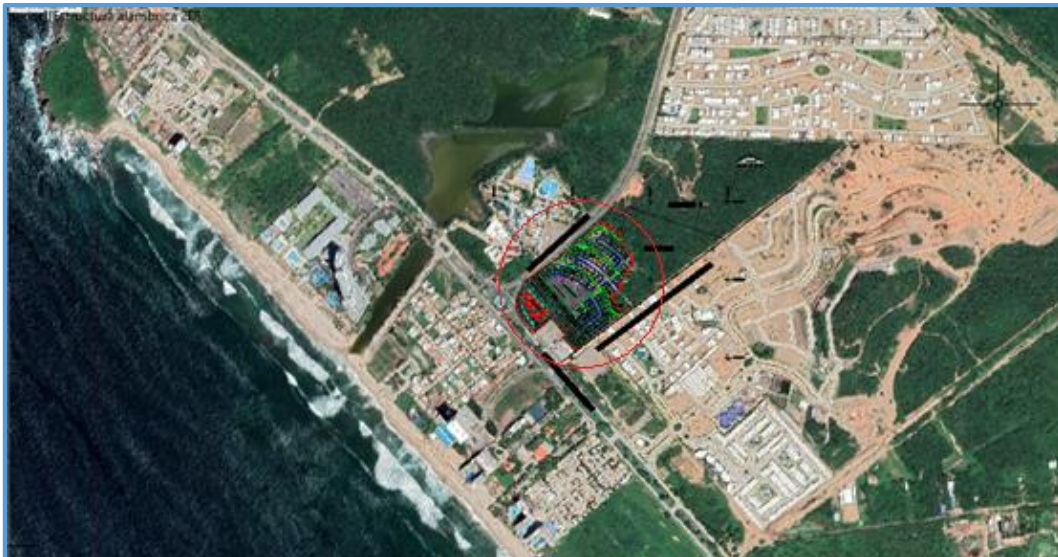
Figura II.2.- Localización del sitio del proyecto (área remarcada al centro del círculo rojo), incluido trazo de obras. Fuente Archivo KMZ del sitio del proyecto.
