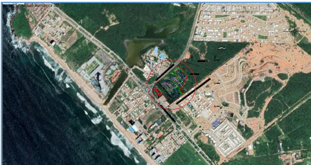
Figura. VII. 1. Escenario actual del entorno del proyecto. En color rojo el contorno del área aproximada que ocupará el proyecto. Al interior del polígono se marca las obras y/o impacto causado por el desarrollo inmobiliario y el uso del espacio natural en la zona de estudio
