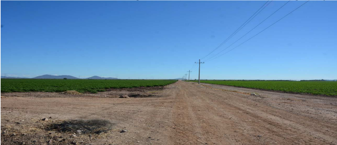
Figura No. 2. Línea eléctrica existente a lo largo del camino que conduce al ejido Joaquín Amaro.
