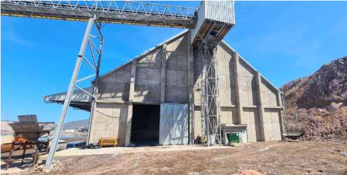
Figura 1. Condición actual de las instalaciones
