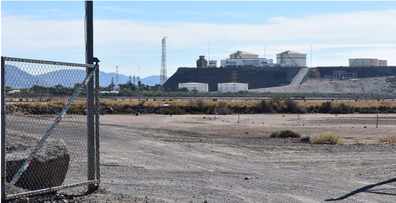
Fotografías 03. El escenario original previo a las actividades de relleno se observa áreas con desniveles con referencia a la carretera Los Mochis- Topolobampo, las cuales fueron rellenas con material pétreo.
