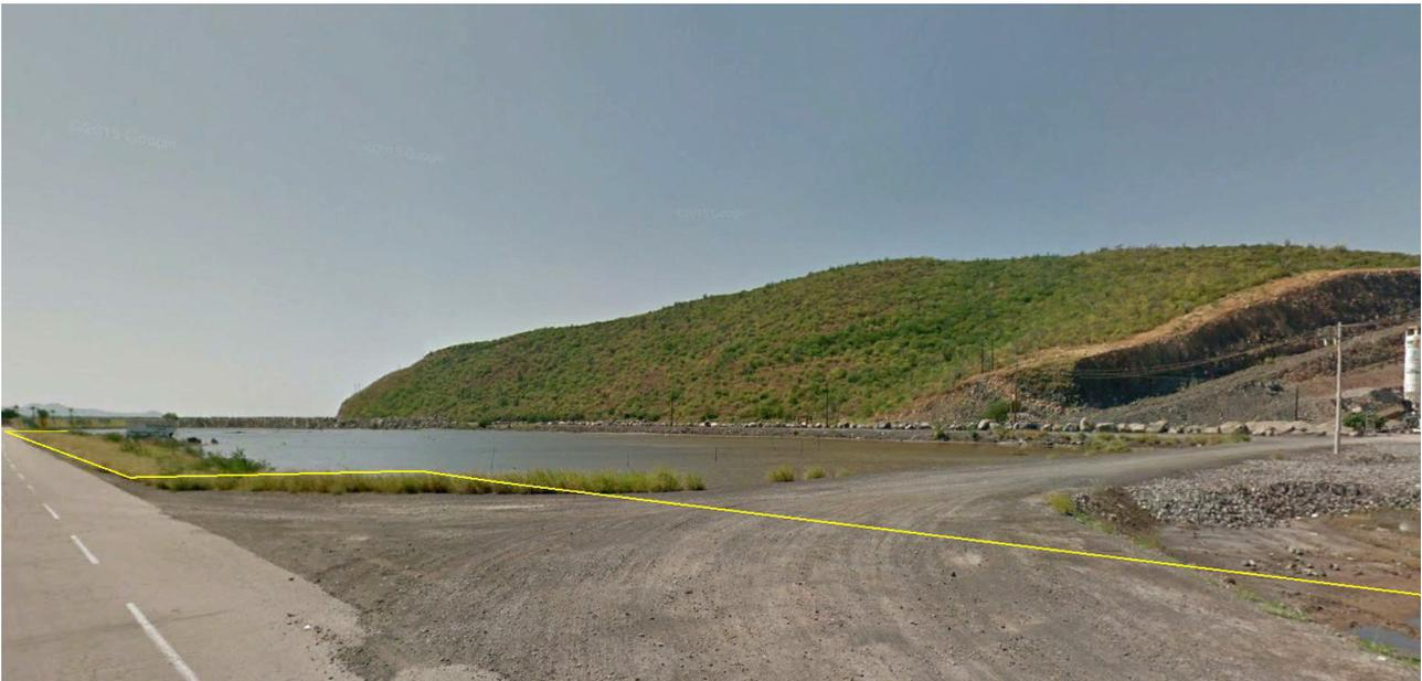
Fotografías 01 y 02 El escenario original previo a las actividades de relleno se observa áreas con desniveles con referencia a la carretera Los Mochis-Topolobampo, las cuales fueron rellenas con material pétreo.
