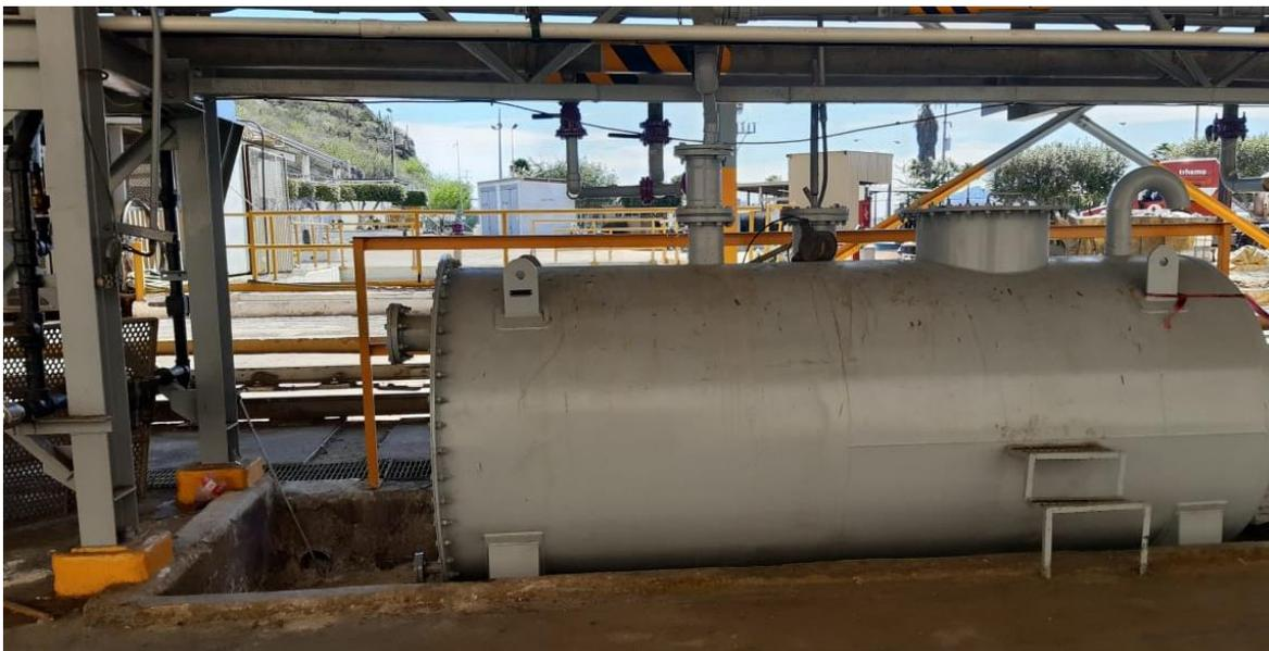
Figura II.6.- Tanque T-18 donde se colecta el H<sub>2</sub>SO<sub>4</sub> resultante de las purgas de las líneas de descarga. El ácido aquí colectado es enviado al tanque T-7.
