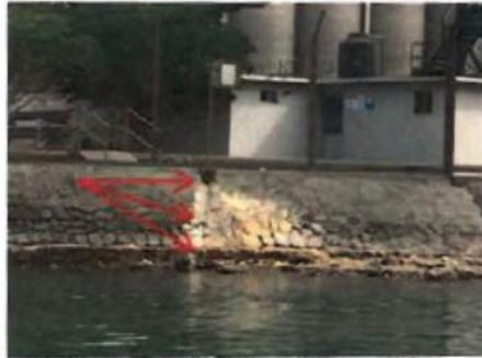
**Punto de salida del ácido sulfúrico al mar (rastros color amarillento)**
