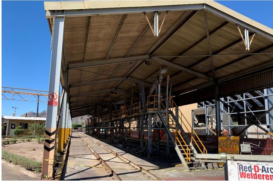
Figura II.5.- Plataforma para la descarga de ácido sulfúrico.
