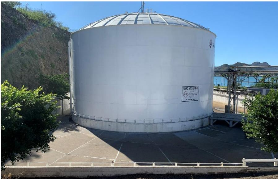
Figura II.8.- Tanque de transferencia T-7, localizado en el interior de un dique de contención de derrames.
