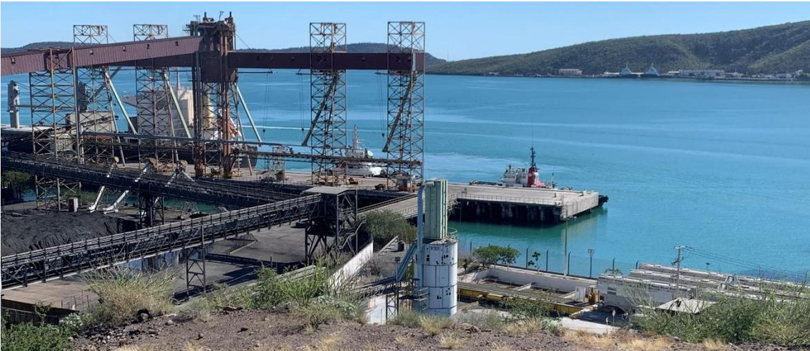
Figura II.10.- Área de embarque de H<sub>2</sub>SO<sub>4</sub> a buques tanque. Del lado izquierdo el rack que sostiene la tubería proveniente de los tanques T-8, T-9, T-10, y T-11. El tanque cilíndrico vertical al centro es el T-19.
