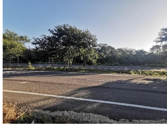
Imagen 2. Colindancia Este del polígono del proyecto donde se establece una calle pavimentada.
