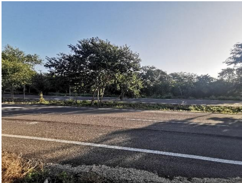
Fotografía 4.6. Colindancia Este del predio donde se observa una vialidad tipo avenida de asfalto.
