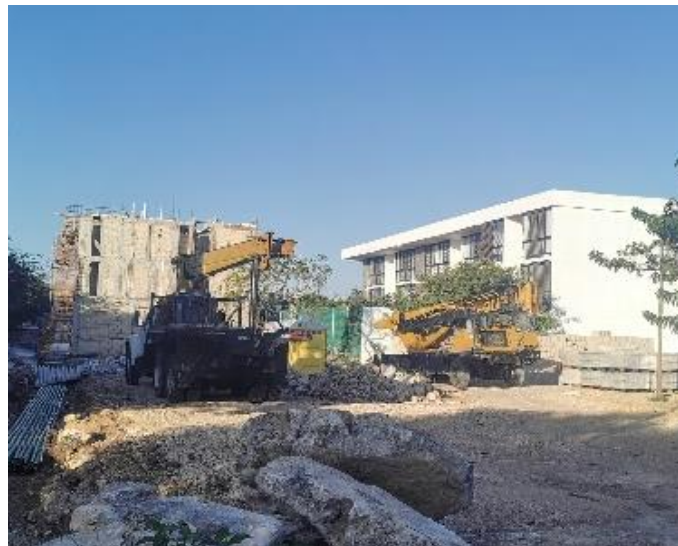
Fotografía 4.4. Colindancia Norte donde se observa una edificación en desarrollo.
