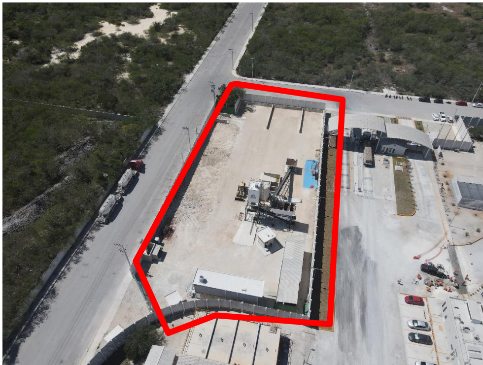
Figura IV.13. Panorama del predio bajo estudio, vista desde DRON en la cual se pueden observar el área verde que se tiene.
