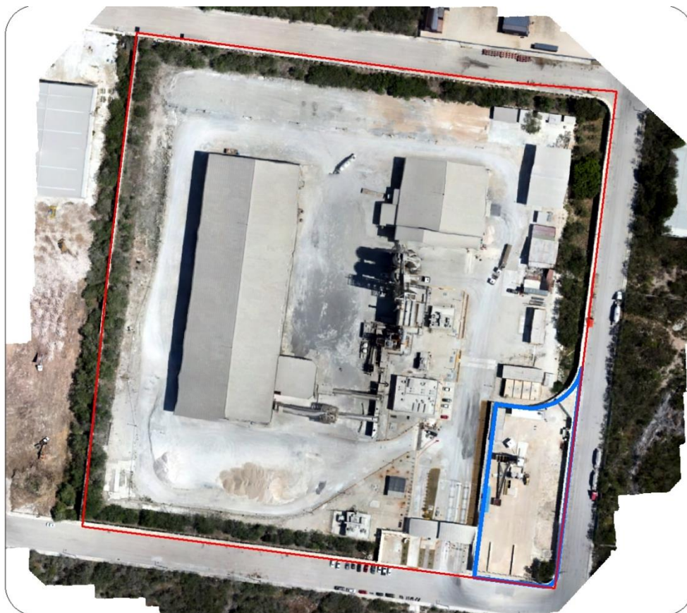
Figura II.1. Vista desde dron de la planta de concreto (recuadro azul)
