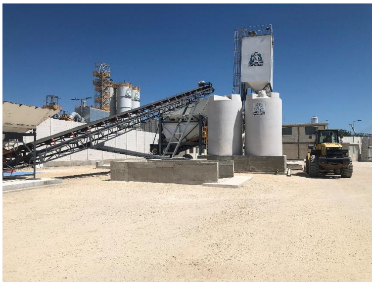
Figura II.3. Silo de almacenamiento.
