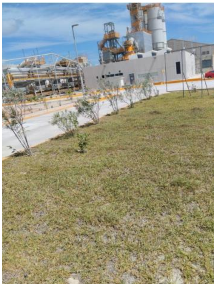
Figura IV.14. Vista de las áreas verdes dentro del proyecto
