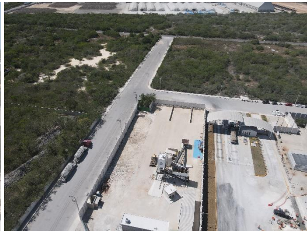
Vista de la planta de concretos
