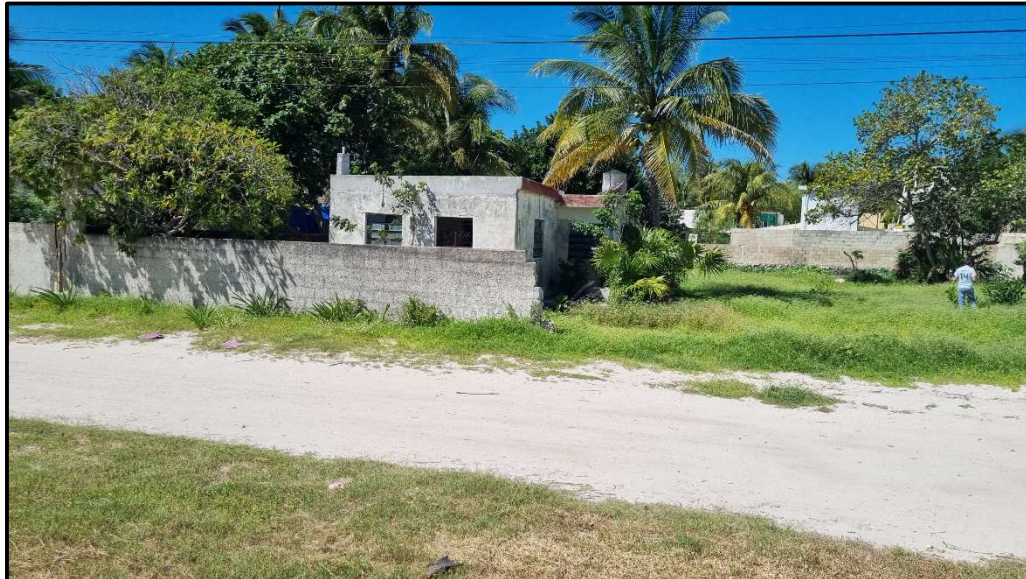
Fotografía 2. Imagen actual del predio vista desde la calle 4.
