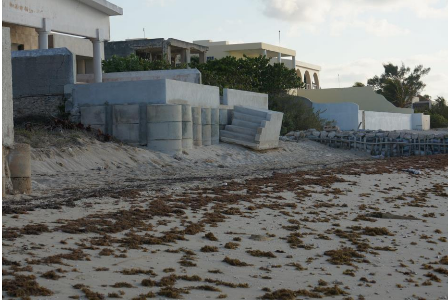
Fig. 4.4. Condiciones en las que se observa la zona de playa en el área de influencia.
