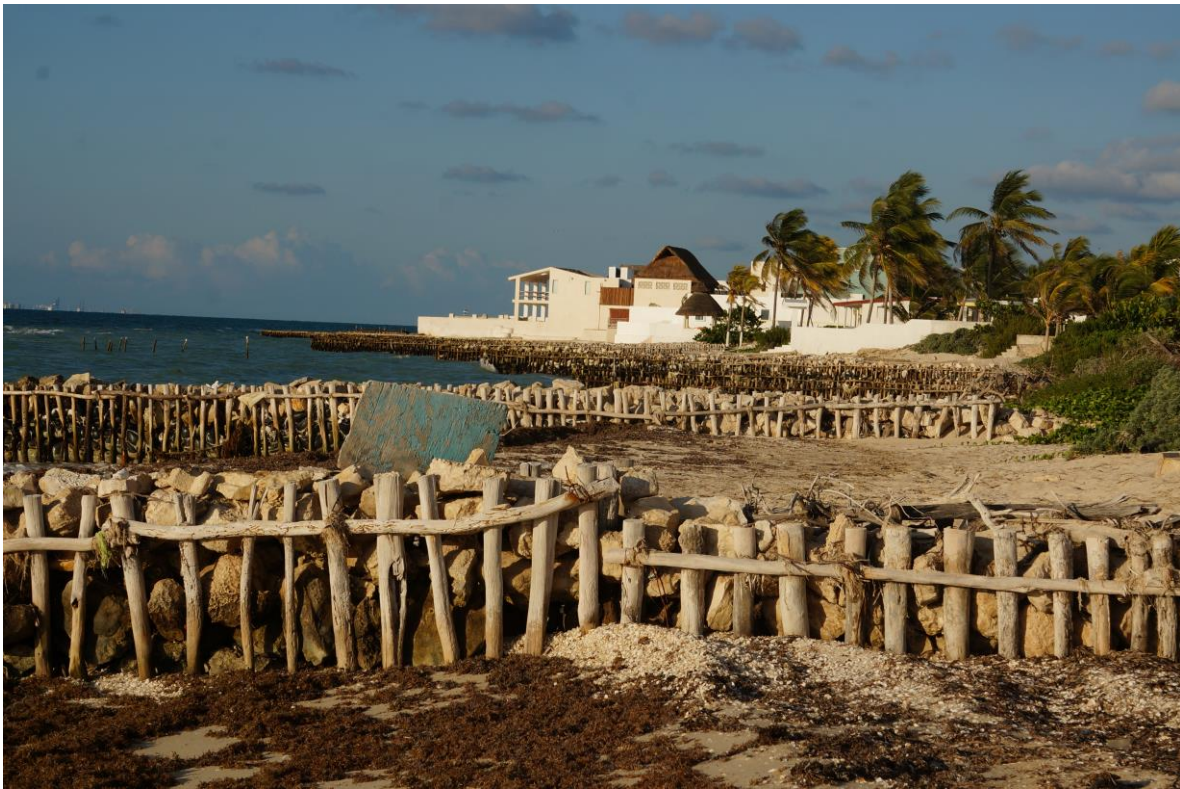
Fig. 4.3. Espigones colocados para contrarrestar los severos problemas de erosión costera en el área de influencia del proyecto.
