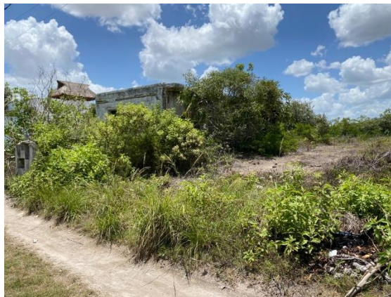
Fotos IV.2. Colindancia con vivienda en abandono.
