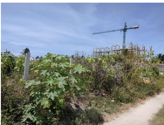
Fotos IV.3. Procesos constructivos en la zona y colindancia norte con predio delimitado y vegetación secundaria.
