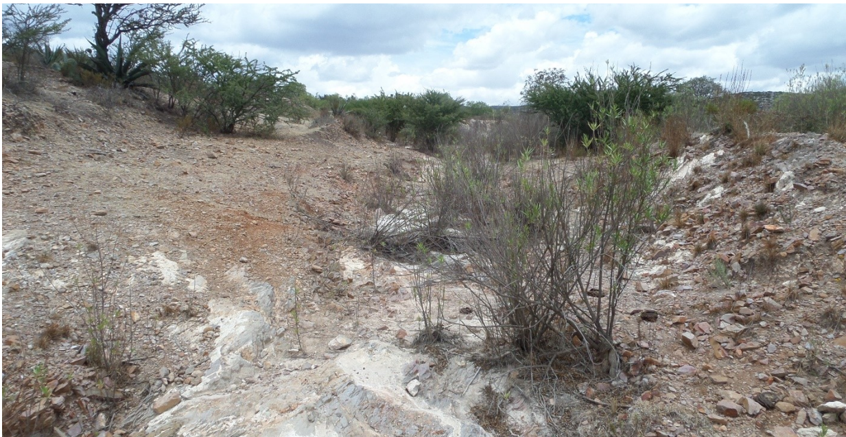
Ilustración 24.- Cunetas como obras de contención y desviación de escurrimientos pluviales
