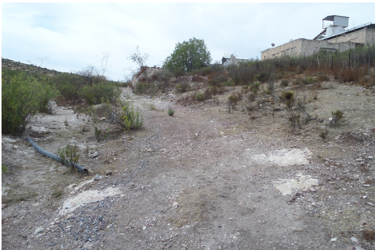
Ilustración 11. - Caminos a rehabilitar
