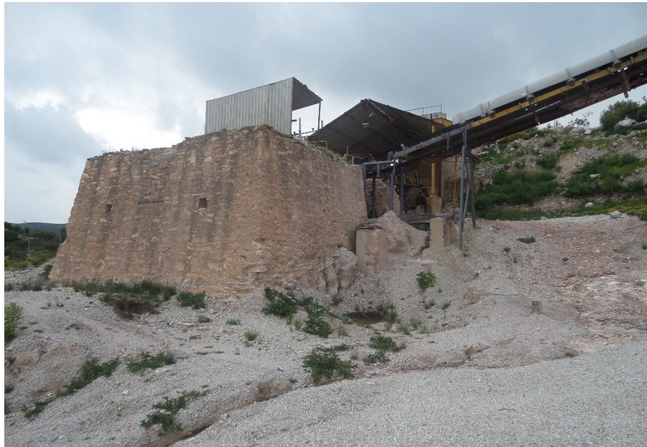
Ilustración 14.- Vista del área de trituración a rehabilitar
