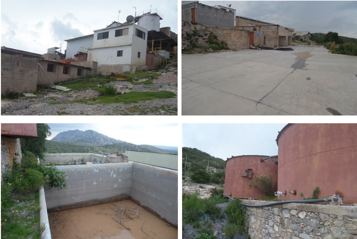
Ilustración 17.- Vista Exterior de áreas auxiliares a rehabilitar
