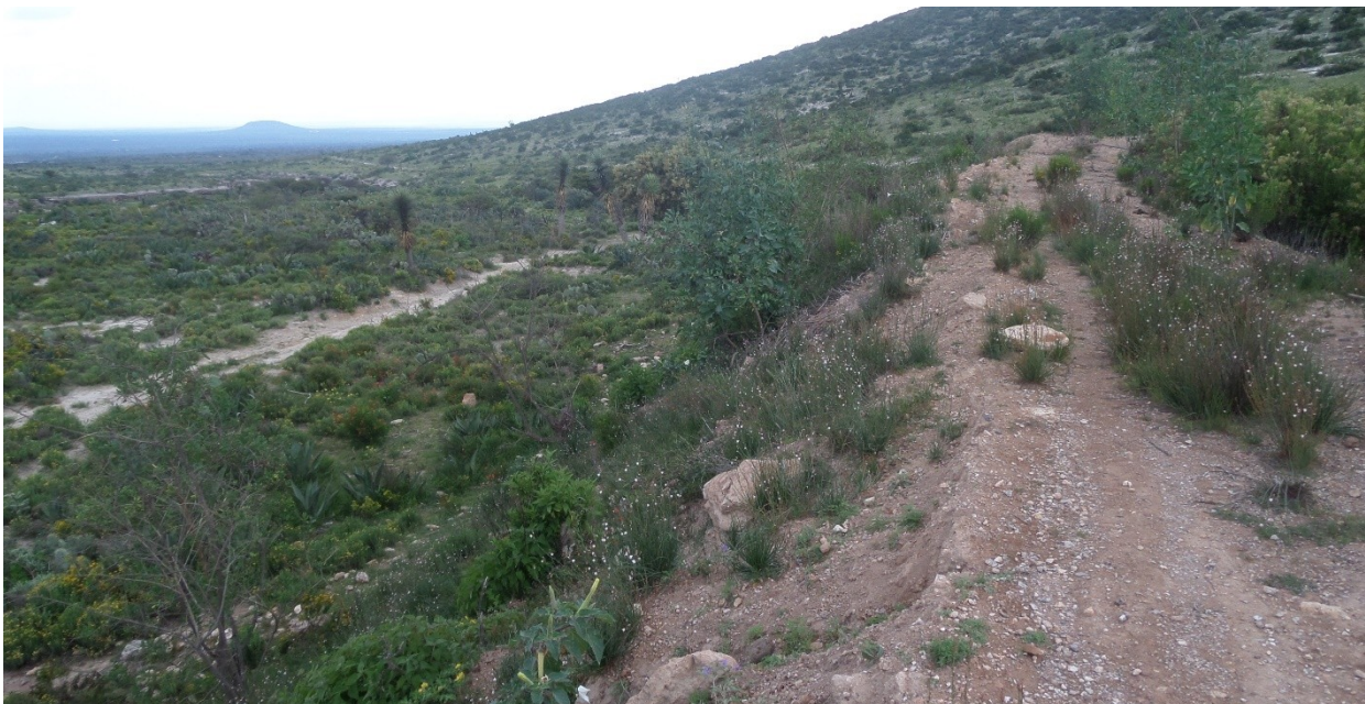
Ilustración 6.- Condiciones sobre el muro de contención del depósito de jales
