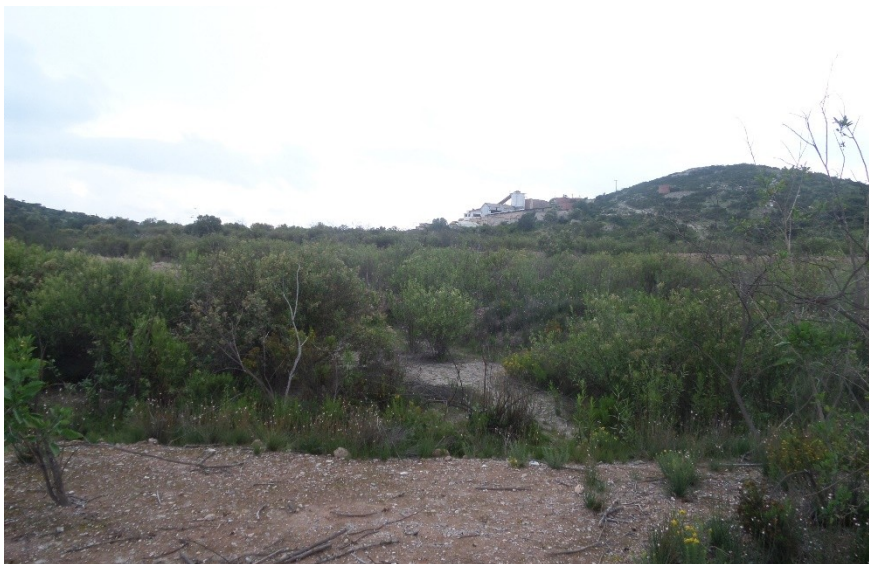
Ilustración 23. Condiciones en las que se encuentra el vaso de la presa de recuperación de las aguas de contacto
