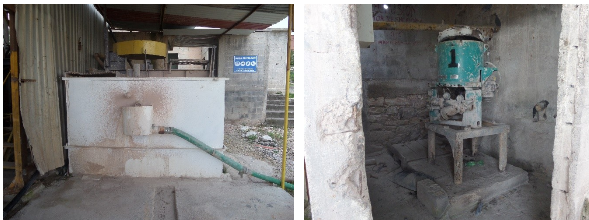
Ilustración 15.- Vista Exterior e interior del área de molienda y clasificación a rehabilitar
