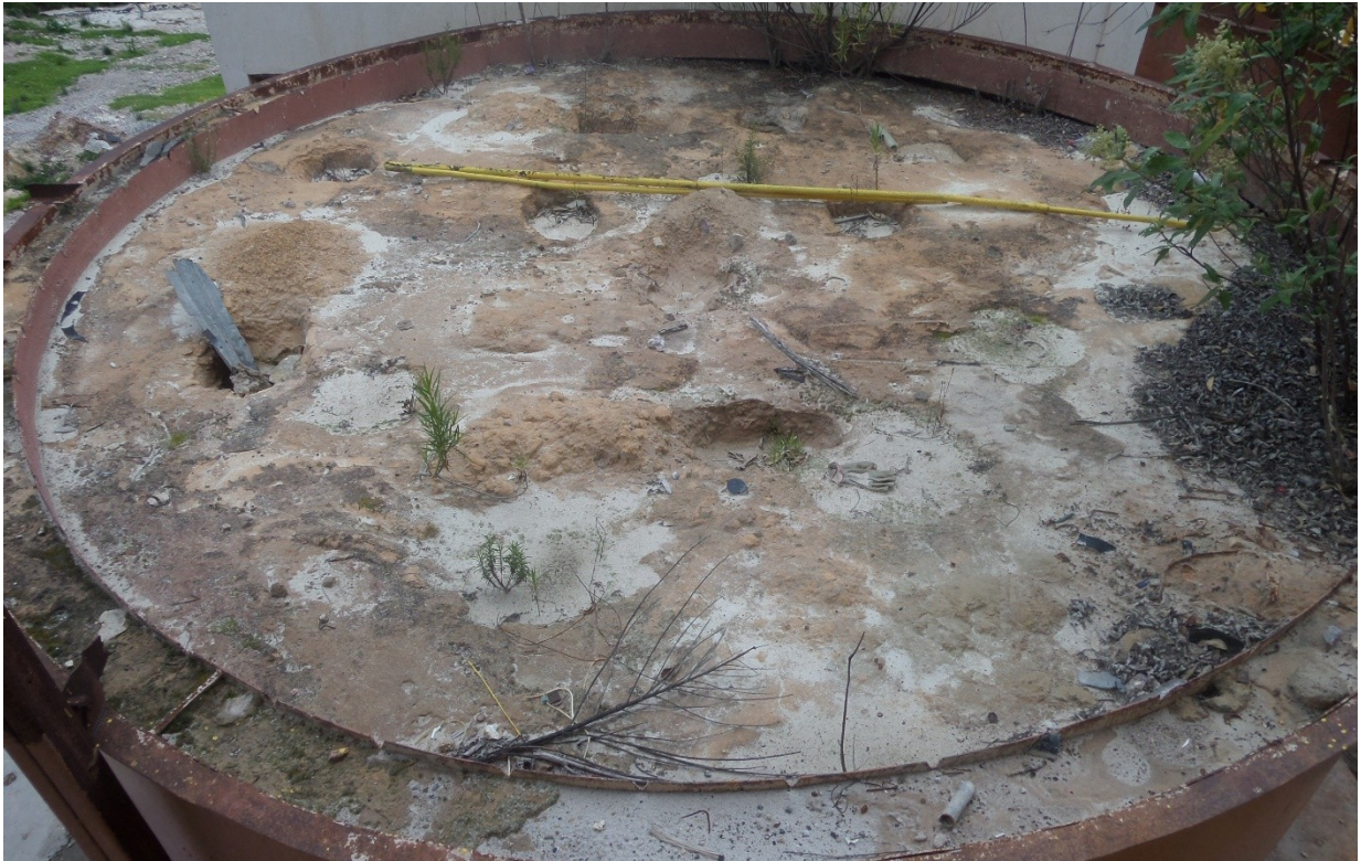
Ilustración 19. - Tanque azolvado.
