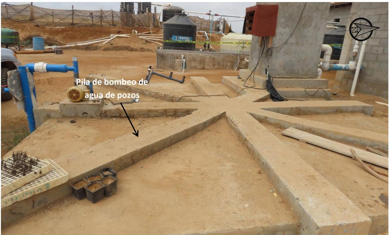
**Foto 4.** Pila de re-bombear de agua de pozos para la alimentación de la planta desaladora.
