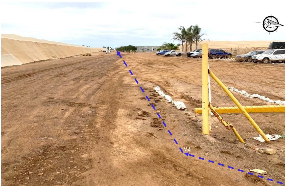
Foto 16. Continuación de la línea de conducción en línea recta sobre el camino de acceso del Rancho VEMA.
