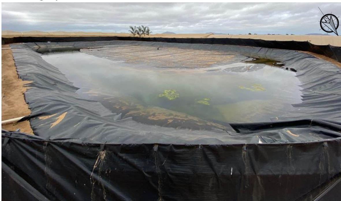
Foto 9. Reservorio que en la actualidad se utiliza para almacenar el agua de pozos que mantienen una buena calidad. Cuando esté operando la planta desaladora será el reservorio del agua producto y pozos con salinidad hasta 1000 mg/l de SDT.
