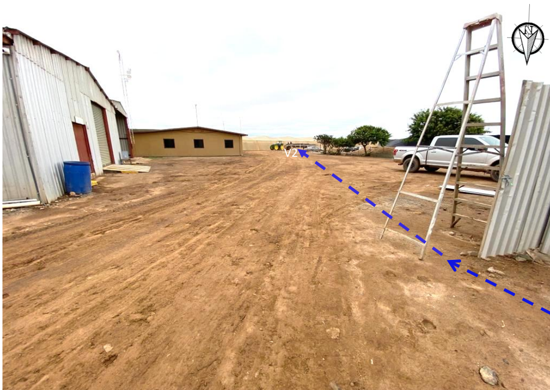
Foto 15. Vista de la continuación de la tubería de conducción del agua de rechazo.
