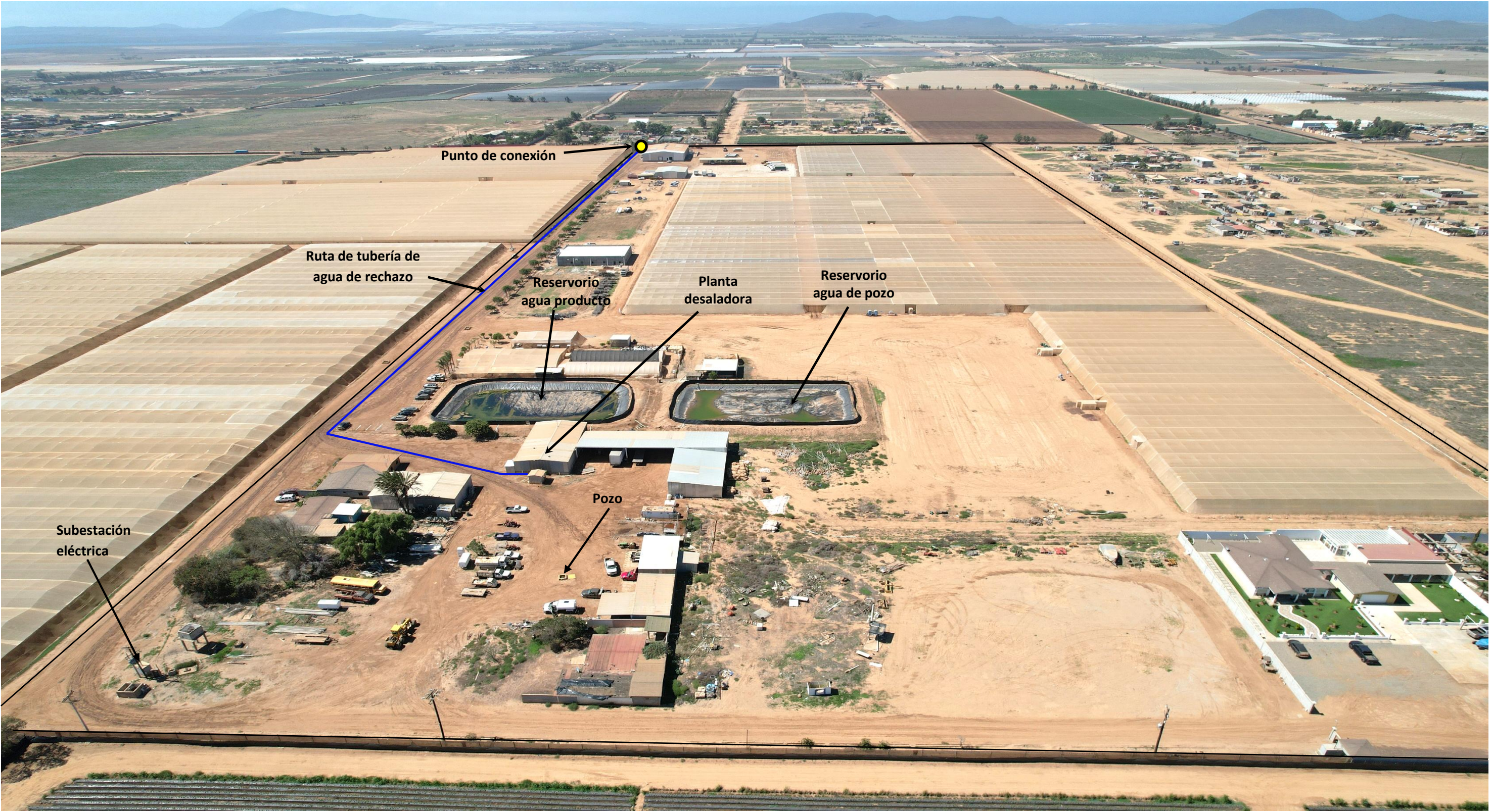
Foto 23. Fotografía aérea que muestra la ubicación del proyecto. La planta desaladora y obras complementarias en la parcela 8 Z-1 P-2 del Ejido Nuevo Mexicali (Polígono negro).
