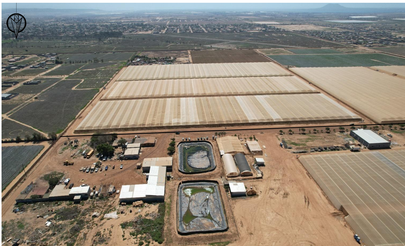
Foto 20. Vista aérea hacia el sur. El Rancho VEMA colinda con una parcela de agricultura protegida, seguida de terrenos sin uso aparente y el poblado Lázaro Cárdenas.
