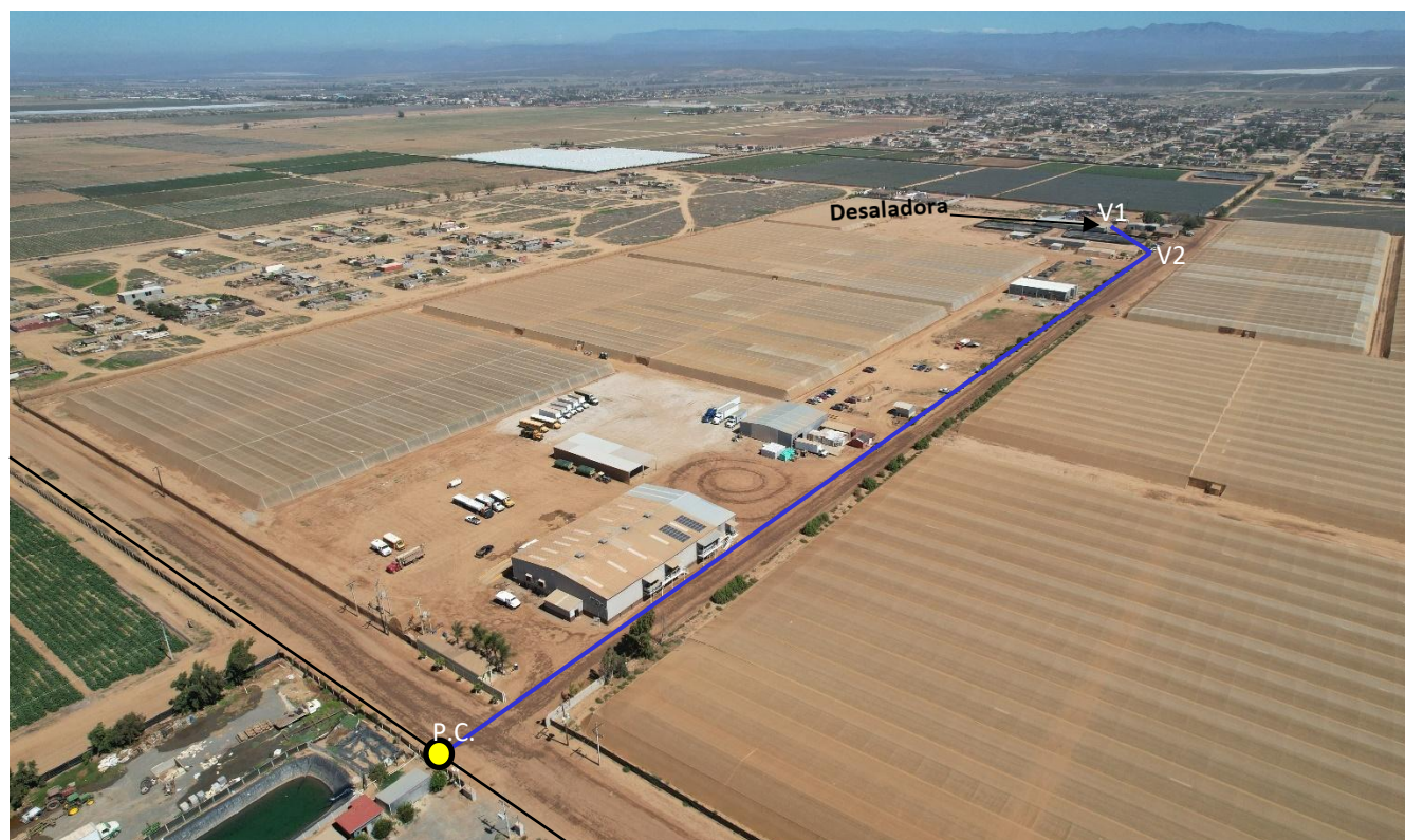
Foto 12. Fotografía aérea que muestra la línea de la tubería del agua de rechazo (color azul) desde la planta desaladora hasta el punto de conexión (círculo amarillo) con la línea de tubería de SM Invernaderos S. de R.L. de C.V. (línea de color negra). En la tabla 3 se presentan las coordenadas de los vértices de esta obra.
