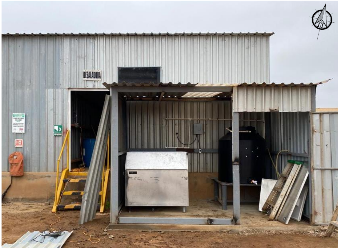
Foto 3. Nave que alberga el sistema de ósmosis inversa, se encuentra unida a la nave de fertilizantes que se usan en la actividad agrícola del Rancho VEMA
