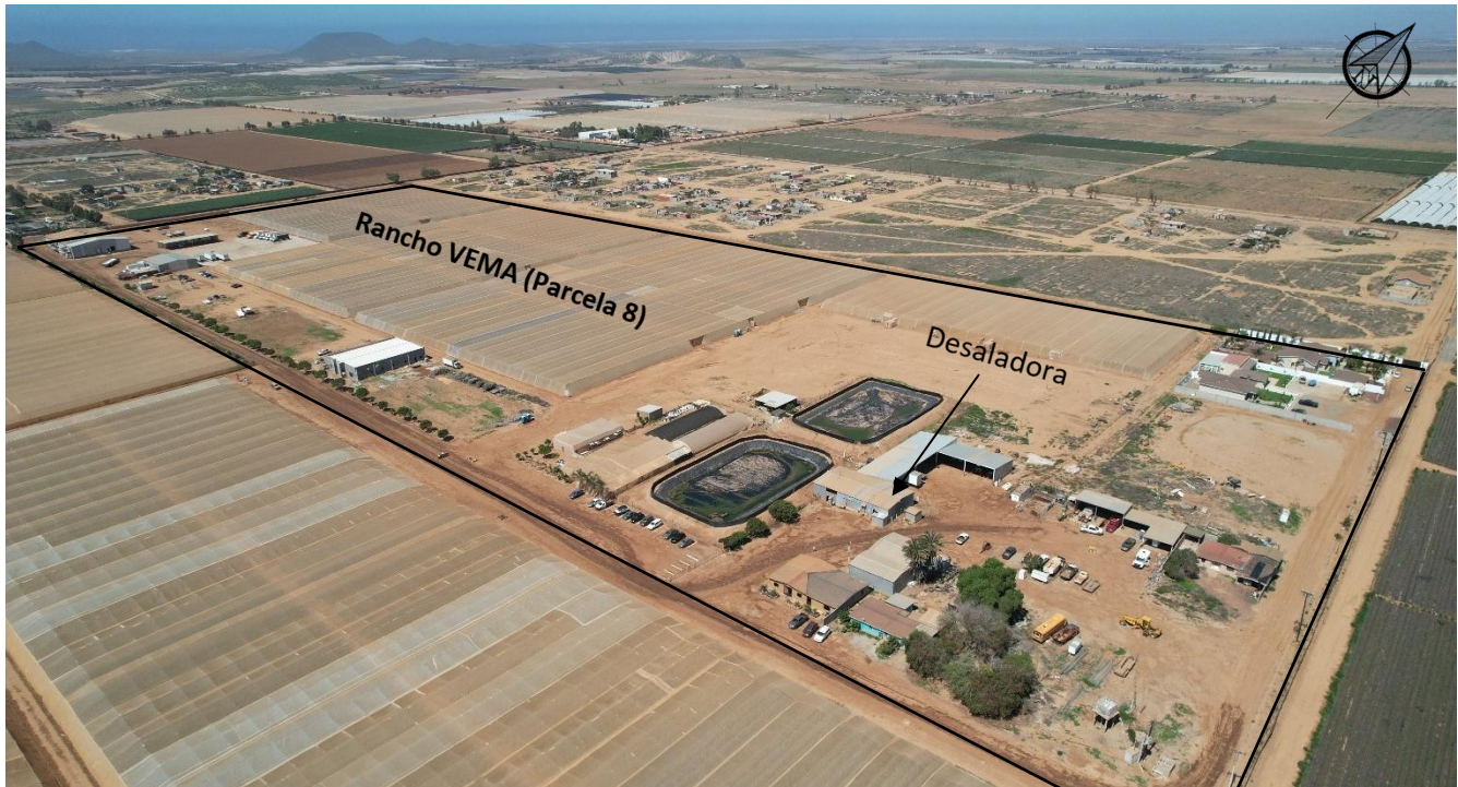
Foto 18. Vista aérea hacia el noroeste del Rancho VEMA (recuadro negro), donde se observan terrenos con actividad agrícola y otros sin uso aparente, además de construcciones habitacionales.
