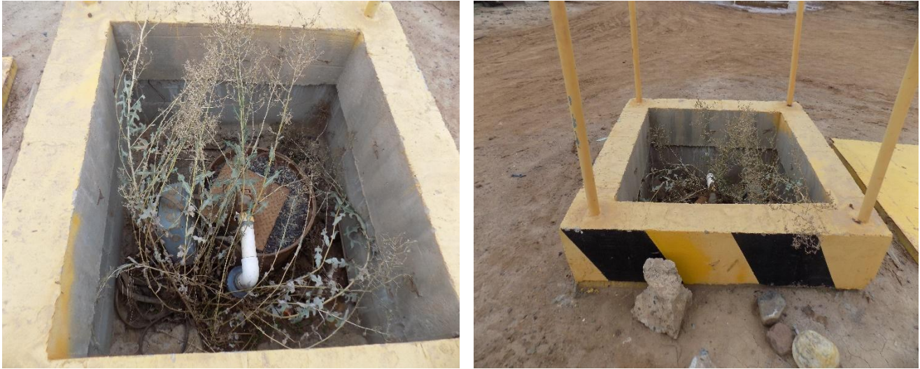
Foto 11. Vista del pozo agrícola que alimentará a la planta desaladora: Pozo con título de concesión No. BCA831677.
