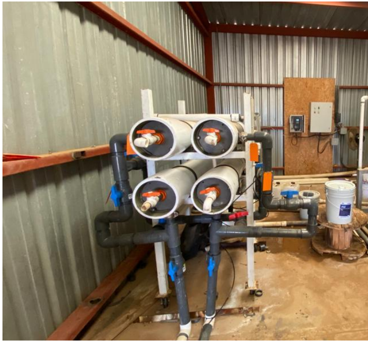
Foto 7. Vista del sistema de lavado de membranas.
