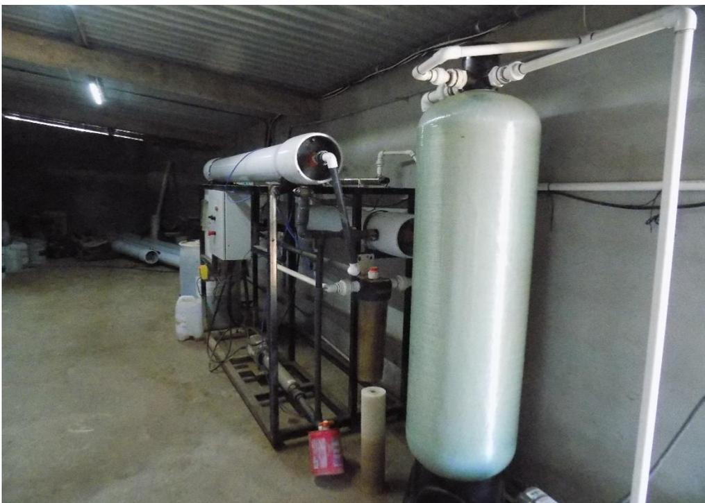
**Foto 3.** Sistema de ósmosis inversa instalado en el interior de la nave.
