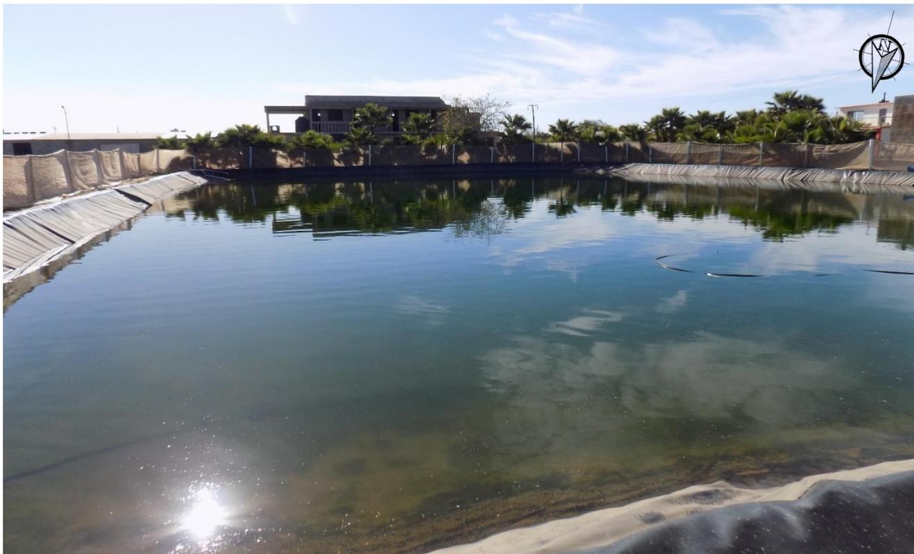
**Foto 4.** Reservorio que en la actualidad se utiliza para almacenar el agua del pozo que se mezcla con la proporcionada por Benjamín Heredia Rojas. Posteriormente se usará para almacenar el agua producto.
