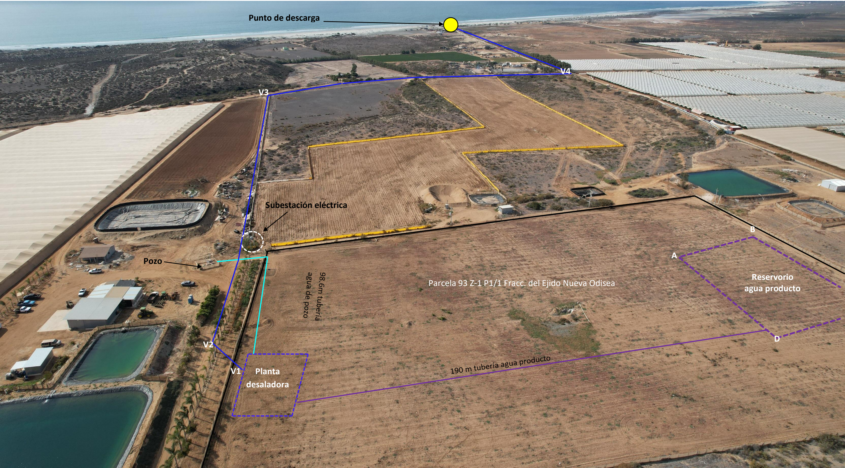
Foto 18. Imagen aérea de distribución de las obras que integran el proyecto. La parcela 93 Z-1 P1/1 Fracc. del Ejido Nueva Odisea se marca con el polígono negro, la ruta de la tubería del agua de rechazo se representa de color azul hasta el punto de descarga en la playa El Pabellón.
