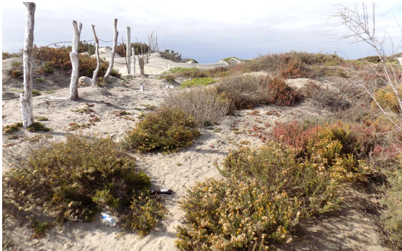
Foto 22. Vista del lado sotavento de la duna costera por donde se colocará 100 m de tubería flexible.
