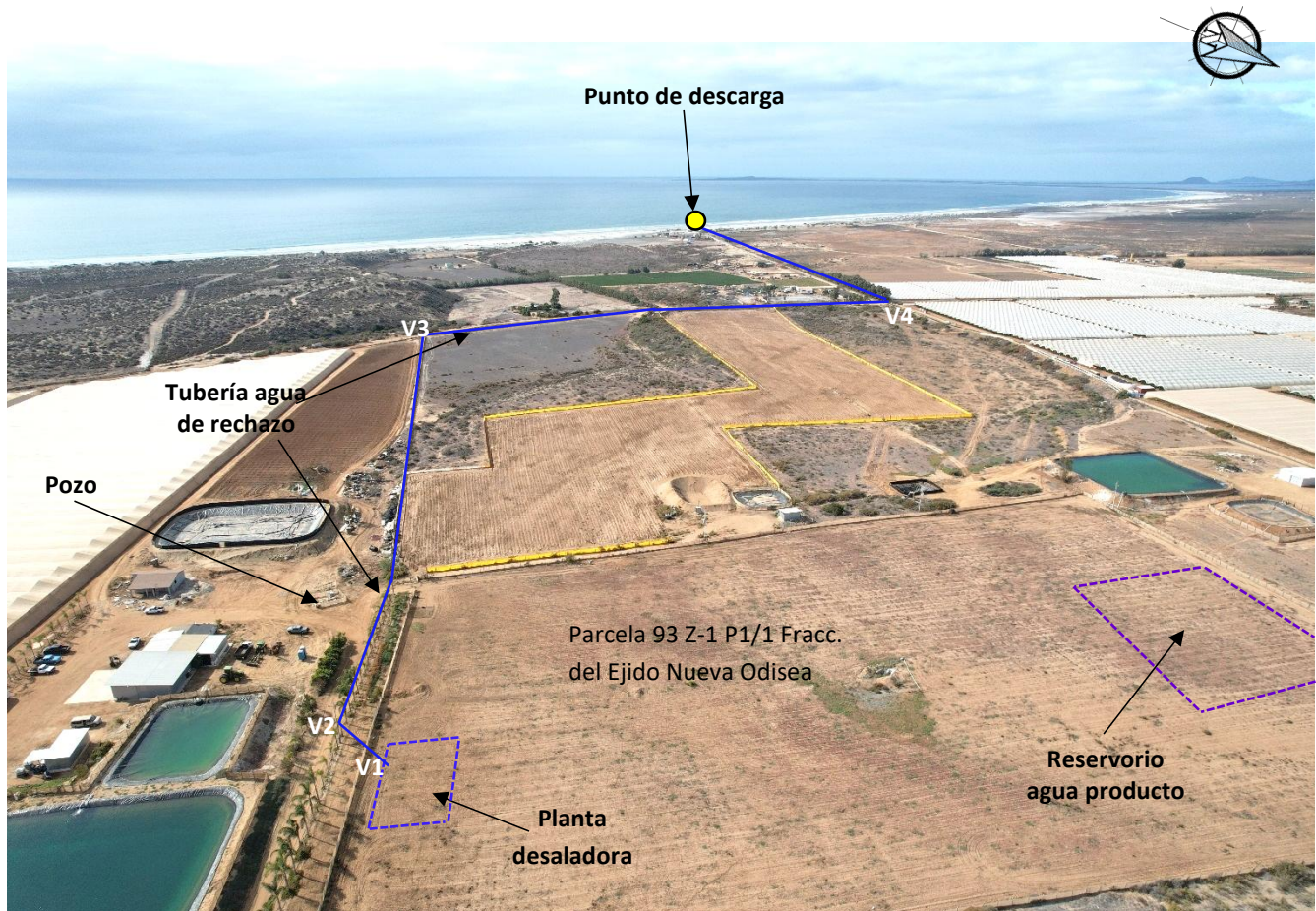
Foto 6. Fotografía aérea que muestra el sitio donde se construirá la planta desaladora, la condición actual de los reservorios y la ruta de la tubería del agua de rechazo al punto de descarga.
