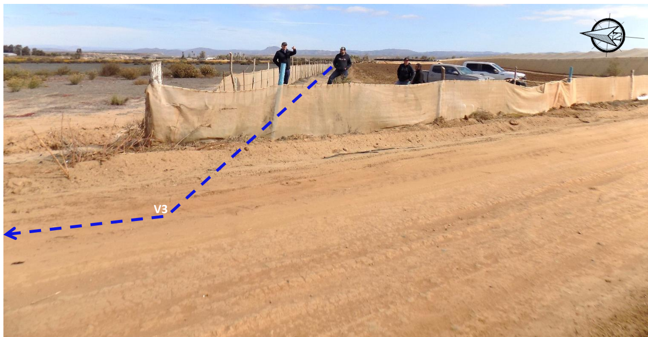
Foto 9. Vista de la llegada de la tubería a un camino de terracería (vértice 3), a partir de este punto se instalarán 1330 m de tubería por un camino de terracería, en las condiciones como se observa en la fotografía.
