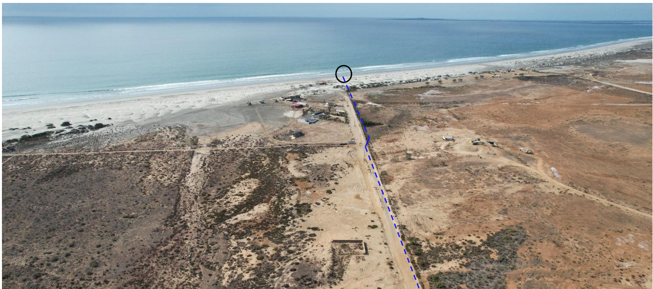
Foto 19. Vista de la zona costera donde el proyecto tendrá influencia directa. La descarga se propone en línea de costa y será necesario cruzar 100 m de duna costera y 46 m de playa seca. El punto de descarga se encierra con un círculo negro y la línea punteada marca la ruta de la tubería.
