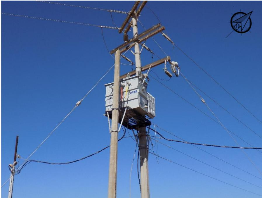
**Foto 5.** Subestación eléctrica de 300 KVA.
