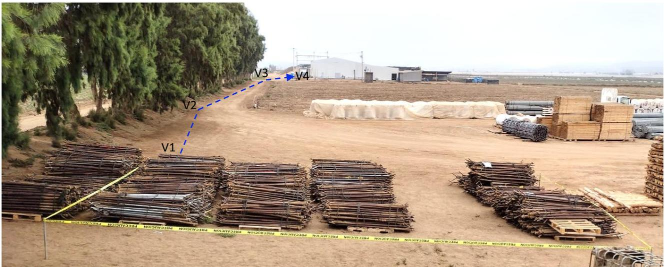
**Foto 9.** La línea de tubería del agua de rechazo abarcará una longitud de 185 m a partir de la planta desaladora, para continuar por el lindero parcelario hasta llegar a la pila que alimenta a la planta desaladora de . Las coordenadas de los vértices V1 a V4 se citan en la tabla 3. |
