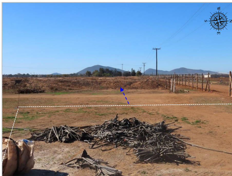
Foto 7. Tubería del agua de alimentación desde la planta desaladora al reservorio de agua producto (línea azul).
