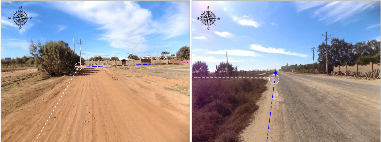
Foto 10. Fotografía del punto donde se conectará la tubería del agua de rechazo (línea blanca punteada) con la tubería que alimenta la planta desaladora de la empresa agrícola SM Invernaderos S. de R.L. de C.V. (línea azul punteada).
