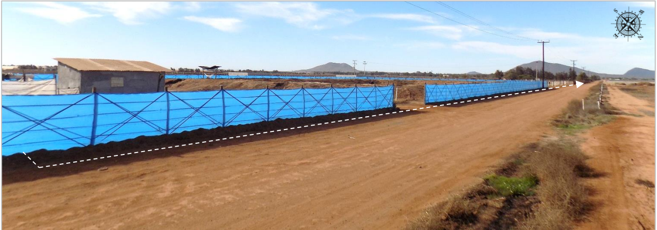
Foto 8. Vista del sitio donde se instalará tubería para conducir el agua de rechazo. El punto inicial es la planta desaladora y continua 1600 m por un camino de terracería en dirección oeste.
