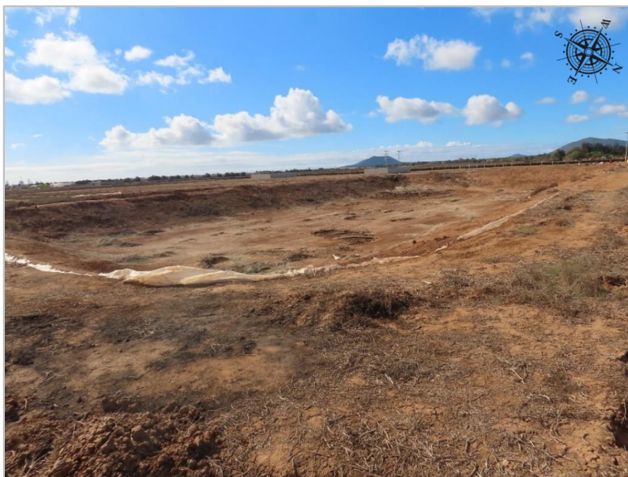
Foto 3. Vista actual del reservorio. Para hacerlo funcional se alisarán y compactarán los bordos y la parte interna de estos se cubrirá de plástico.
