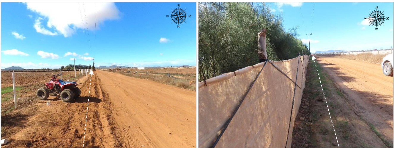
Foto 9. Fotografía de dos tramos de camino por donde se propone instalar la tubería de agua de rechazo. El camino no presenta vegetación que pueda ser afectada.
