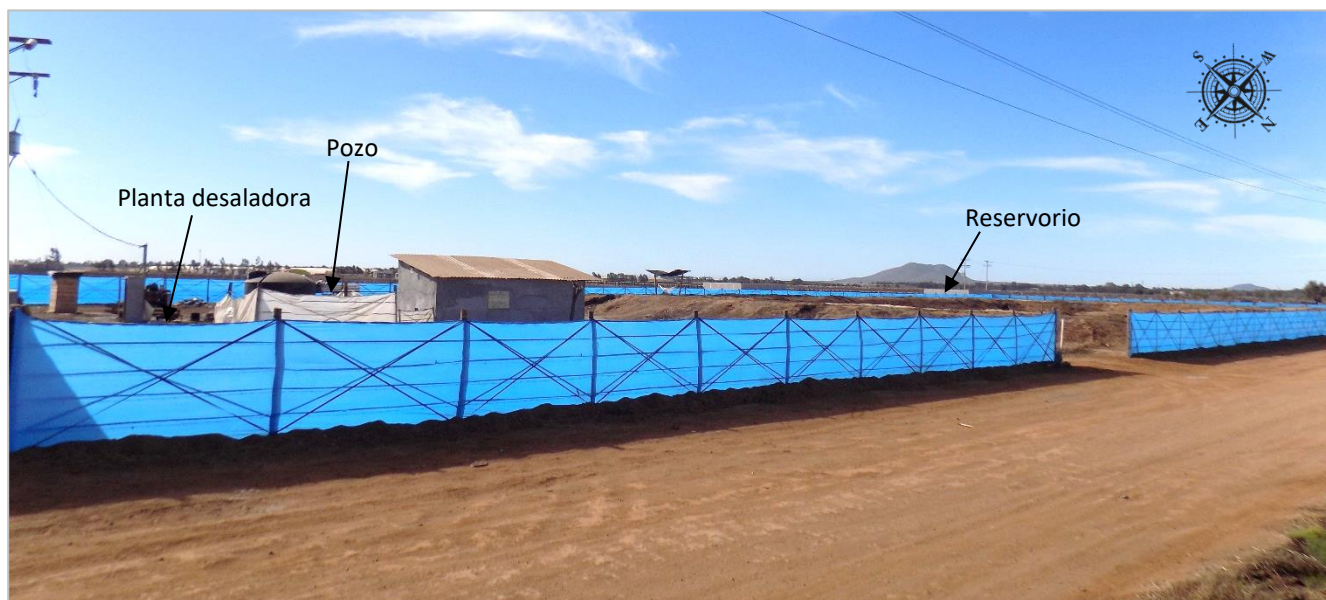
Foto 5. Vista panorámica donde se muestra el sitio donde se construirá la planta desaladora.
