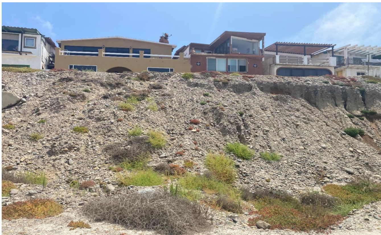
Imagen 8. Vista actual de la zona de preparación y construcción
