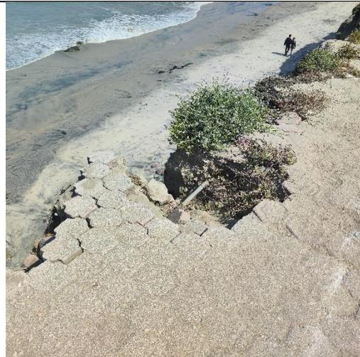
4-. Detalle de la parte superior del cantil con evidencia de erosión.
