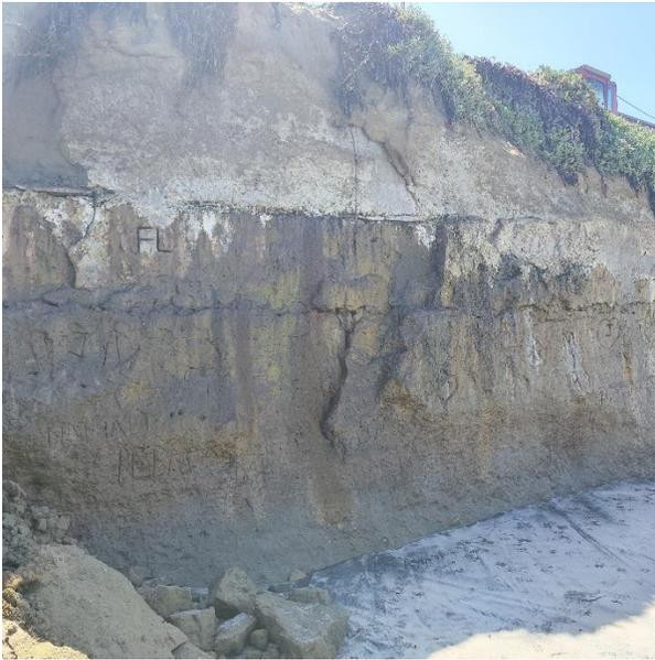
**Imagen 5.** Detalle del cantil en el que se muestra erosión e infiltraciones que lo debilitan.
