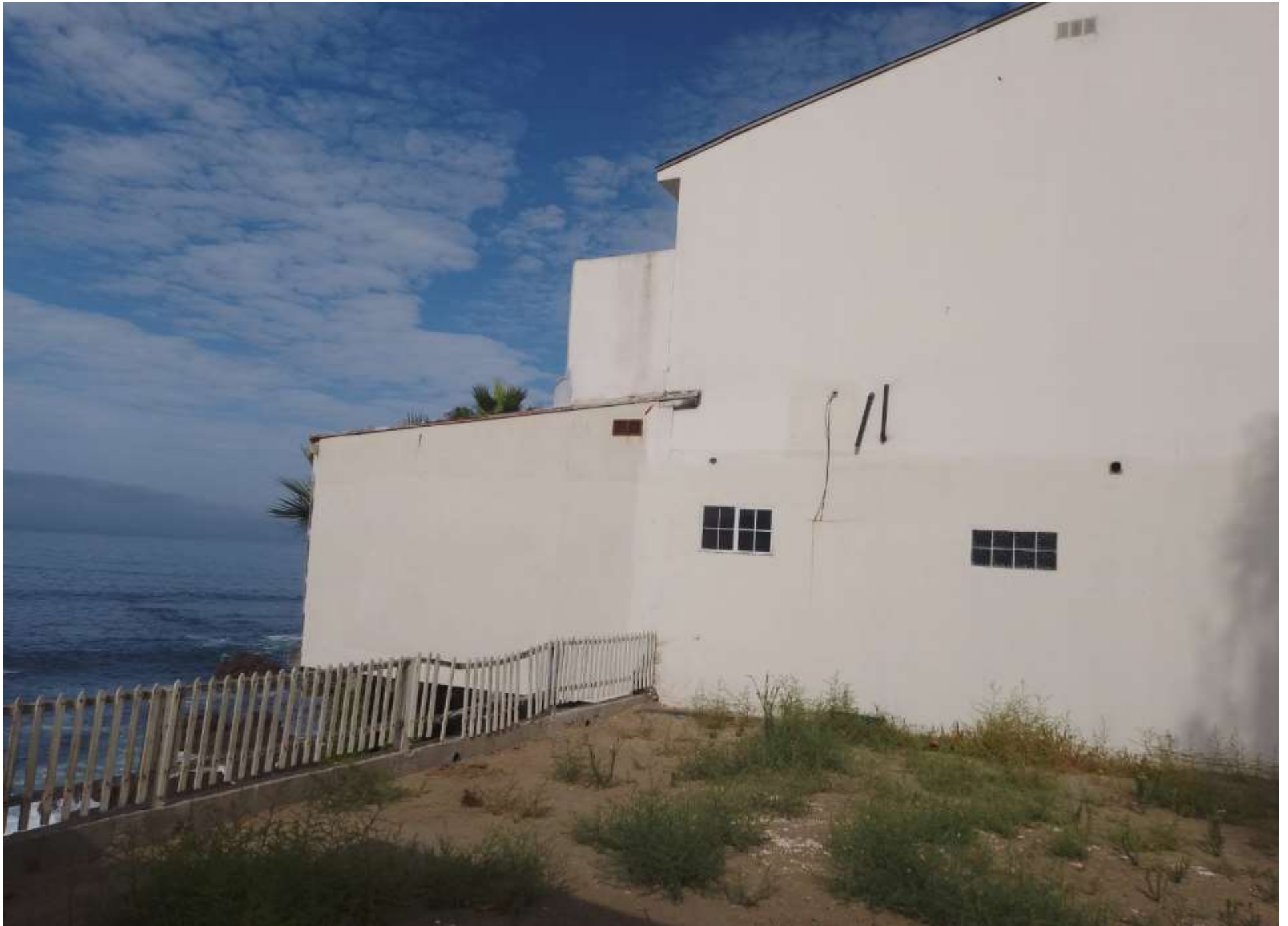
Fotografía 9. Interior de concesión No. DZF-421/91. Orientación Este-Oeste. Casa habitación existente del promovente.
