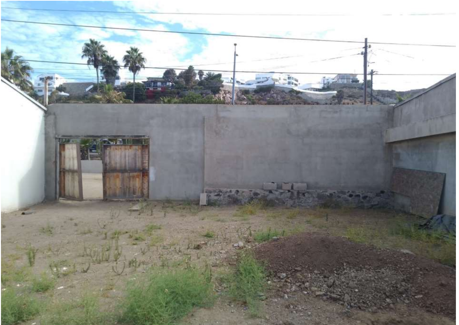
Fotografía 8. Interior de concesión No. DZF-421/91. Orientación Sur-Norte.
